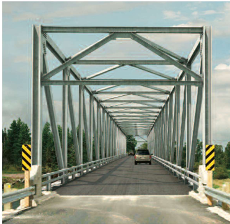
Figur 9-4 Standardisert løsning fra Canam bridges
