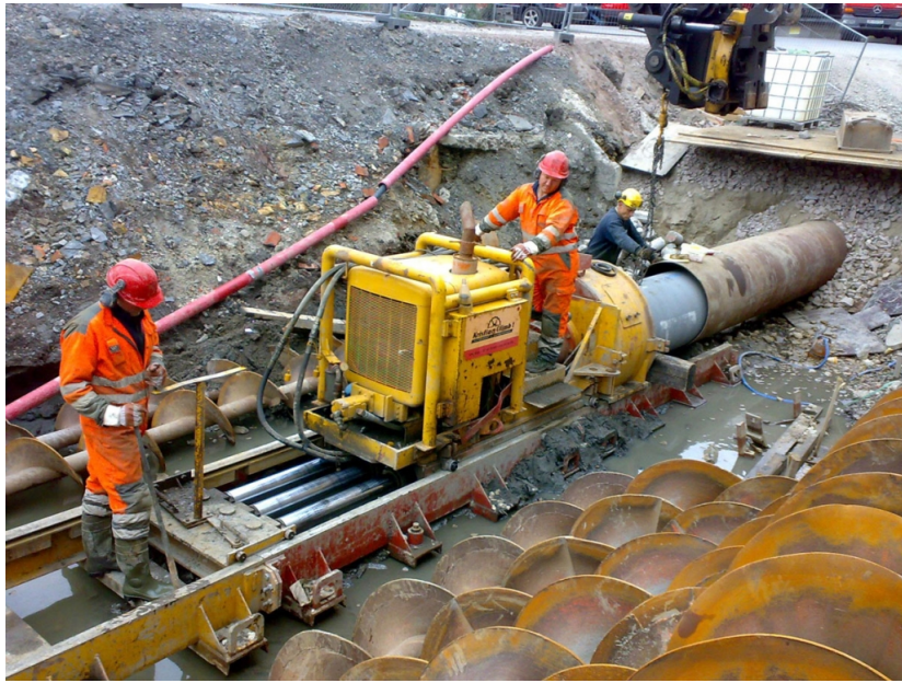
Figur 4: Et eksempel på rørpressing (Olimb, 2018).
