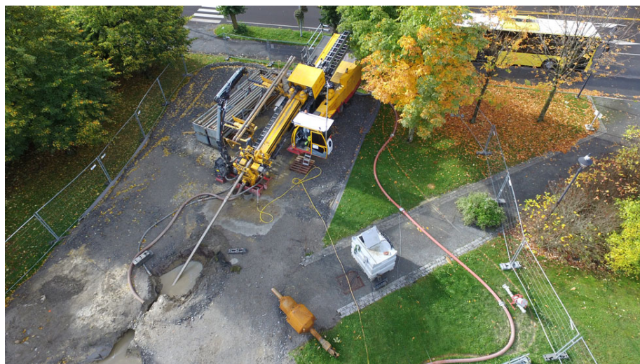
Figur 2: Et eksempel på styrt boring med borerigg (Olimb, u.å.).
