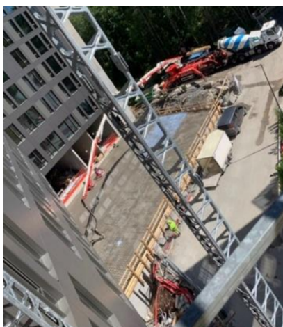
Figur 26: Plasstøpt dekke over parkeringskjeller på Thon Hotell SNØ (Foto: Privat fra sommer 2022).
