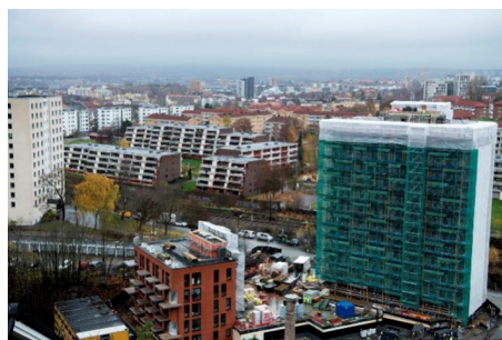
Figur 2: Pågående byggeprosjekt (AF gruppen, 2022).
