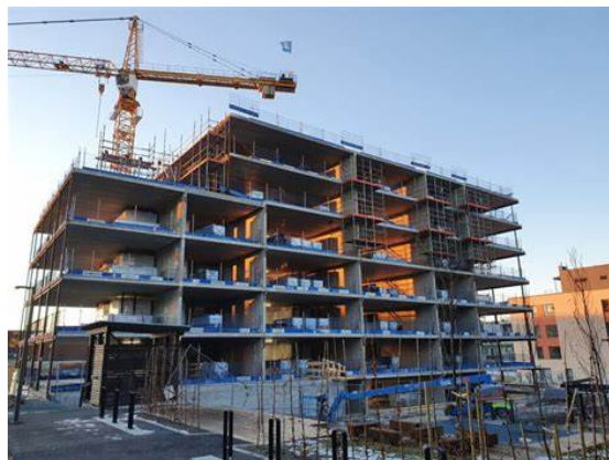
Figur 4: Råbygg i stål og betong (Skanska, u.å.)
