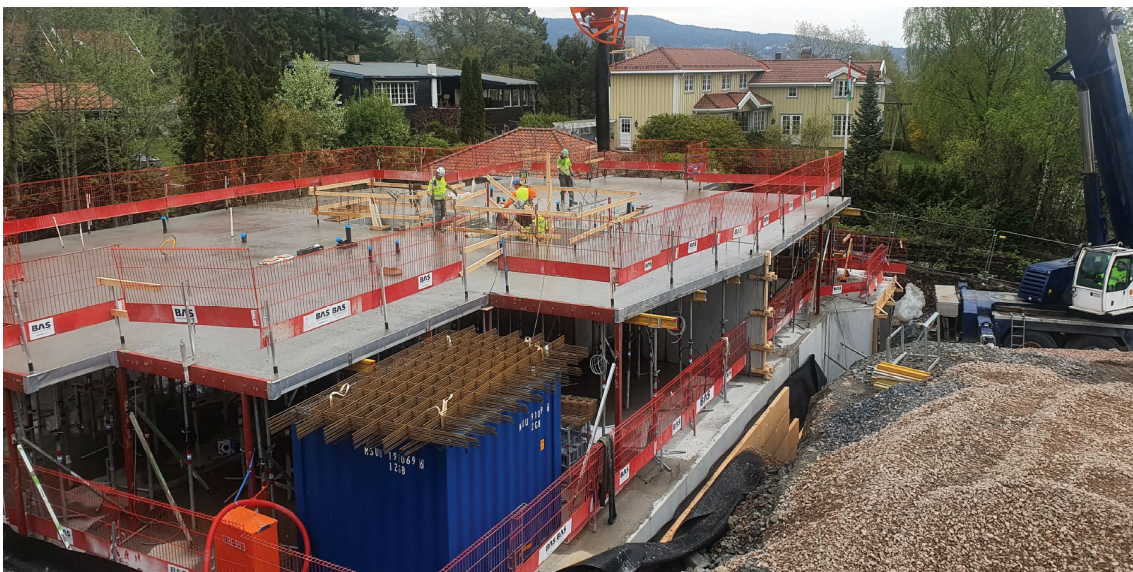
Figur 21: Betongdekker i et råbygg (Råbyggas, u.å.).
