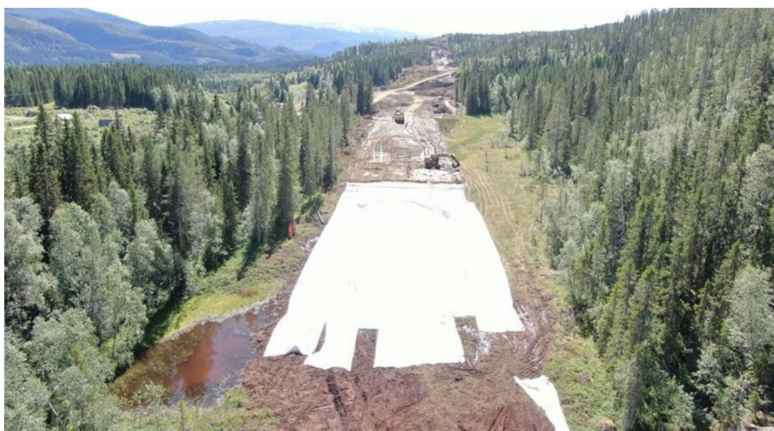
Figur 4.7: Komprimering av myr ved vegbygging [4]
