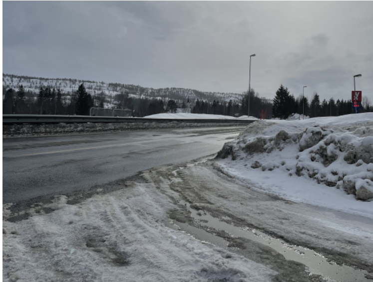
Figur 3.20: Høye brøytekanter i Trones sentrum (fra befarings)
