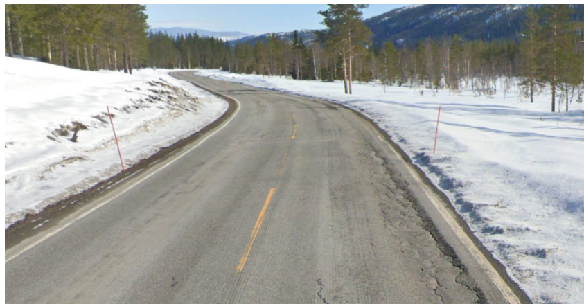
Figur 3.10: Oppsprukket dekke [9]
