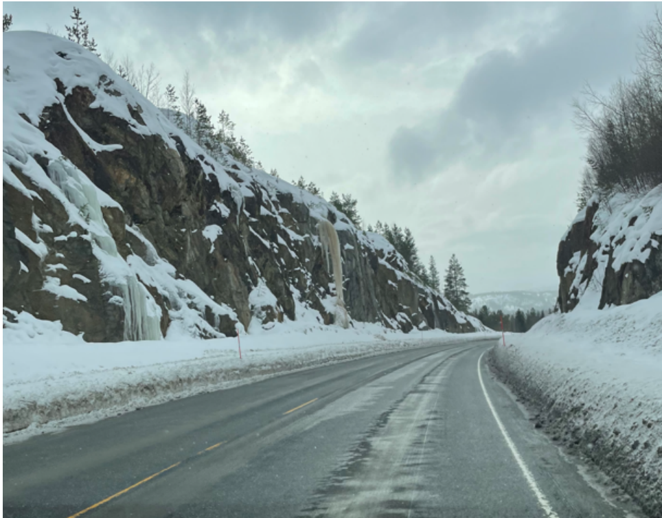
Figur 3.18: Fjellskjæring på begge sider (bilde fra befaring)
