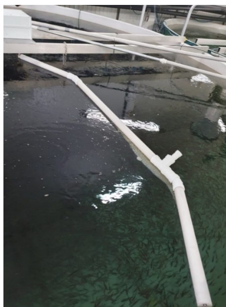
Figur 18: Prototype av form B. Bygd av rørdeler i polypropylen. En kan også se opplegg for avsug installert der organisk materiale er samlet (Foto: Nicholas F. Ødegård)
