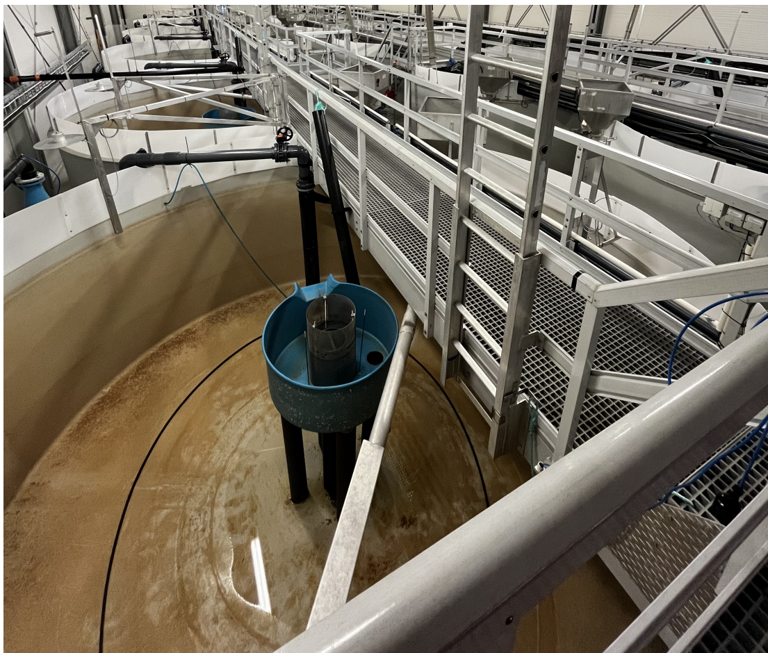
Figur 6: Karene i startføring ved Nordheim er 6 meter i diameter og har en rund utforming. I midten av røret står fish tank cleaneren (i blått) med avløpsrør, rist og rør vil å frakte opp slam og dødfisk fra bunnen av karet. (Foto av Baglo 2023)
