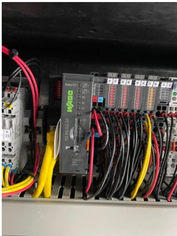
Figur 4: Bilde av WAGO PFC 750-890 på Mariner
