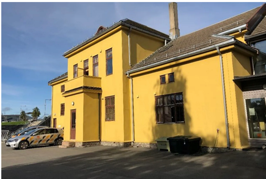
Figur 7. Lademoen stasjon i murkledning (foto: Bane NOR, u.å.).
