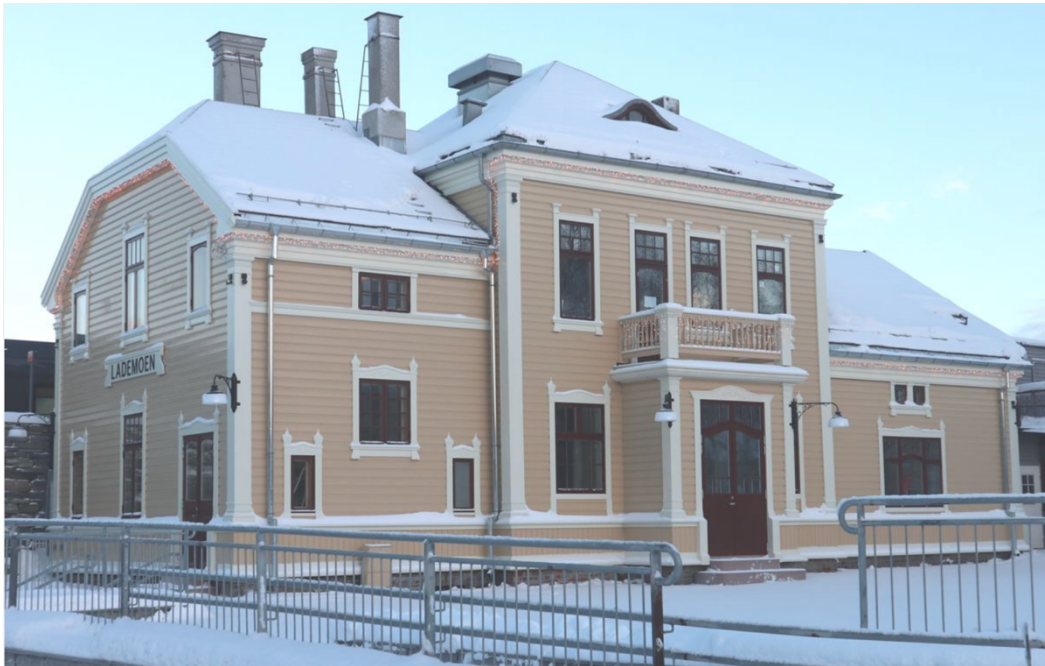
Figur 8. Lademoen stasjon etter tilbakeføringen (foto: Byggeindustrien bygg.no, u.å.).
