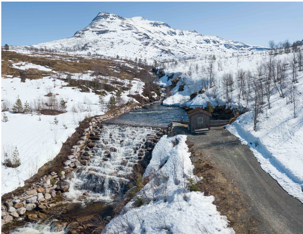
Figur 2.3: Inntaksdammen til et elvekraftverk i Surnadal ved full produksjon under snøsmelting om våren. Foto: Eirik Andreas Mortensbakke
