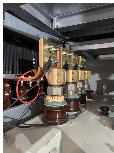
Figur 3.5: Måling på trafo
