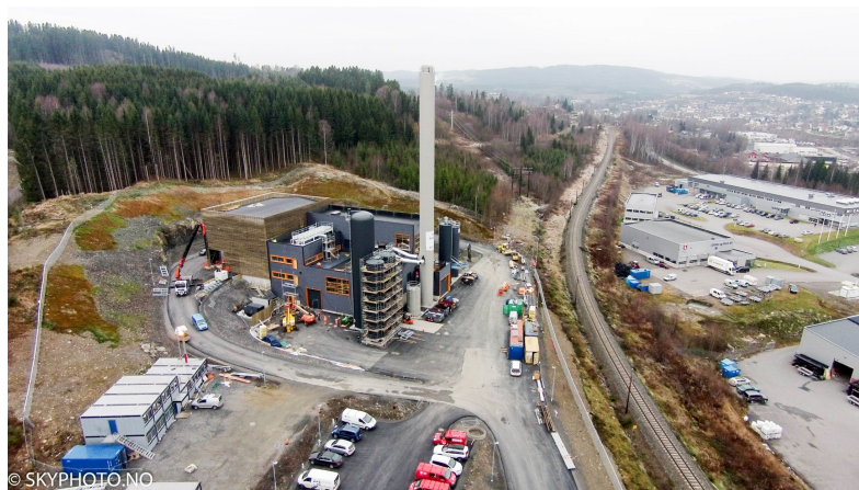
Figur 2.3: Anlegget i Gjøvik under oppbygning [10]
