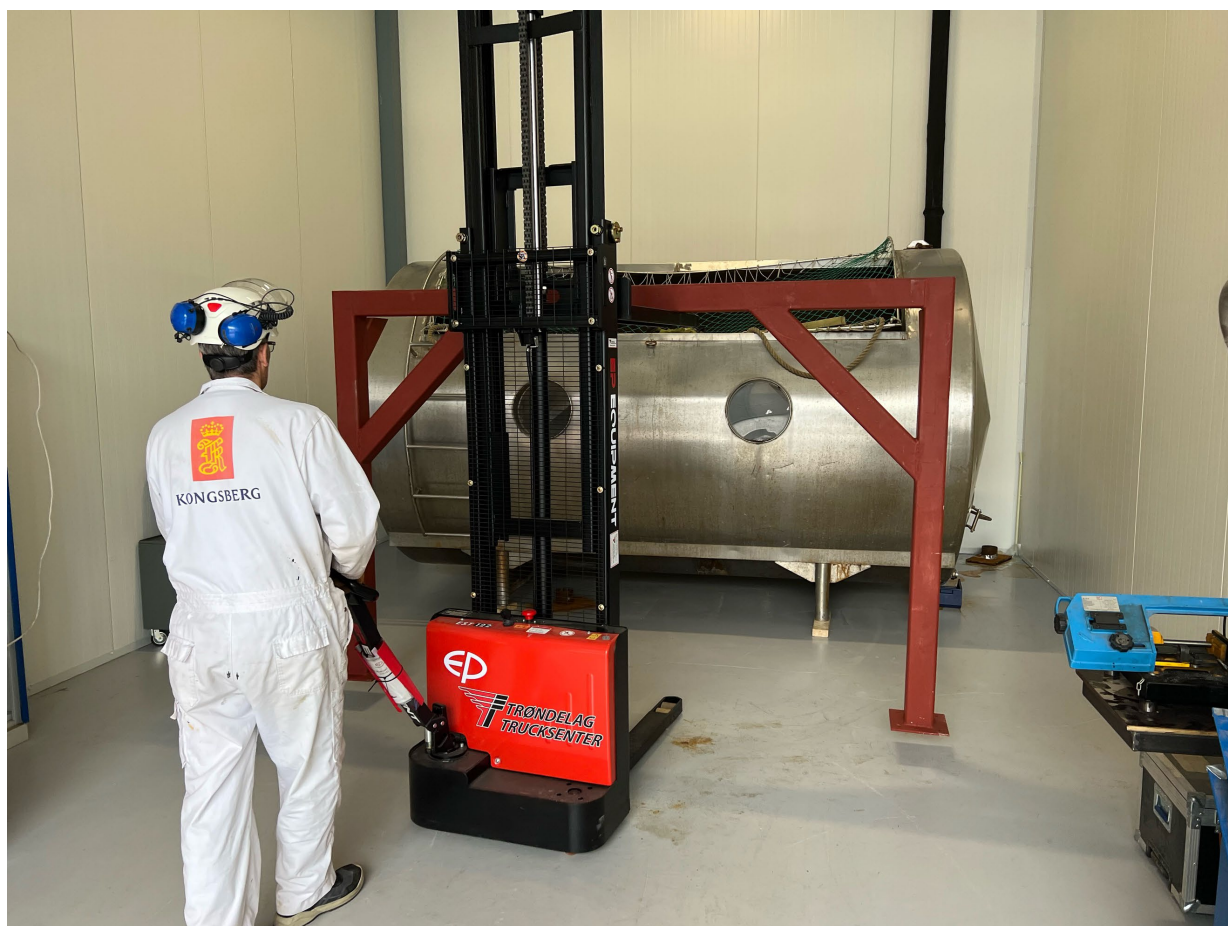
Figur 16: Montering av halvfabrikert ramme
