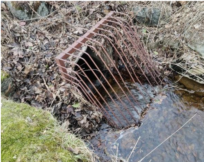
Figur 4 Eksempel på symbolet «menneskeskapt vandringshinder» i form av rist som hindrar stor sjørret frå å vandre opp, og kulvert som i dette tilfellet gjer at det må vere høg flo for at sjørret skal kunne vandre opp.
