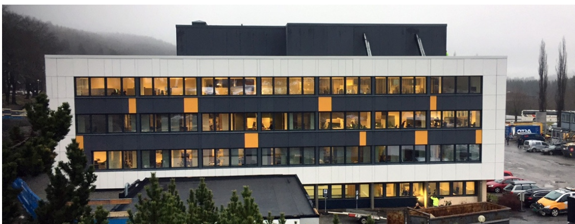
Figur 2: Statens vegvesens kontorsted i Steinkjer (Statsbygg, 2017)
