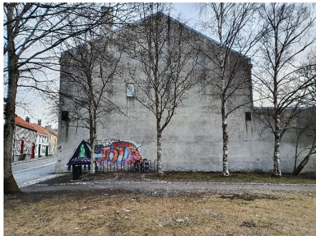
Figur 4.9: Bygningen i sørøst og vegetasjonen her. Foto: Cathrine Fossdal (16.03.20).
