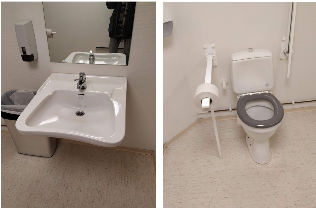
Figur 5-22: Standard, HC-toalettrom. Begge bilder fra befaring.
