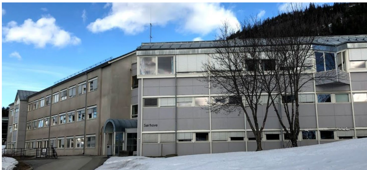
Figur 5-1: Bilde av Sørhove, tatt fra sør. Kilde: Statsbygg. To fasadematerialer: Murt leca og malt kryssfinér.
