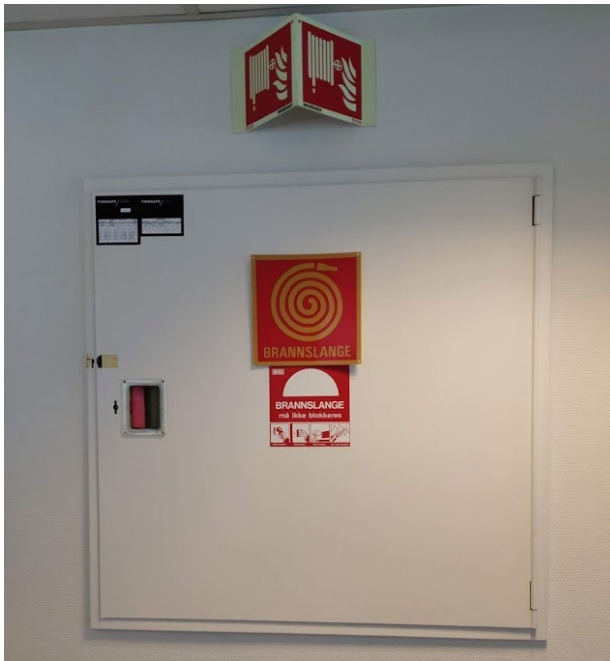
Figur 5-24: Til venstre: Brannslangeskap, bilde fra befaring. Til høyre: Ombrukspotensiale, brannslangeskap.
