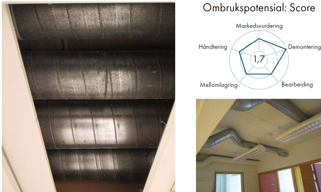
Figur 5-8: Bildet til venstre er tatt under befaring, bildene til høyre er fra WSPs tilstandsanalyse. Ombrukspotensiale, ventilasjonskanaler: Øverst til høyre.
