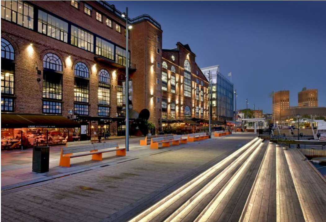
Figur 7. Restaurerte fasader fra tidligere skipsverftet og promenade «Stranda» på Aker Brygge (FOGRA Reklamefoto AS, 2014).
