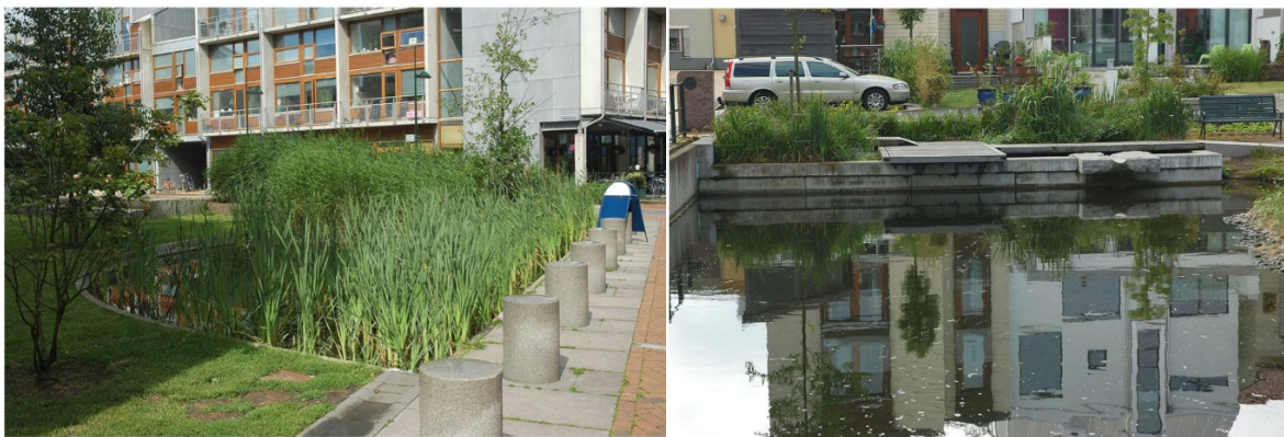
Figur 18: Infiltrasjons basseng for overvannshåndtering (Austin, 2013).
