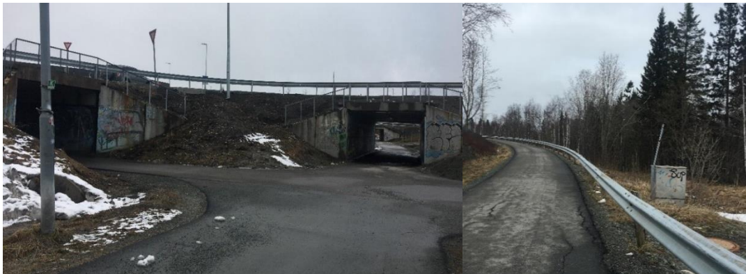
Figur 14: Underganger og gangveier ved Tonstadkrysset.
