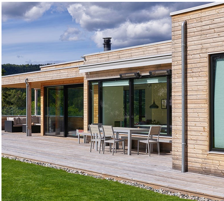
Kompakt tak med utvendig nedløp (Ragnar Hartvig)
