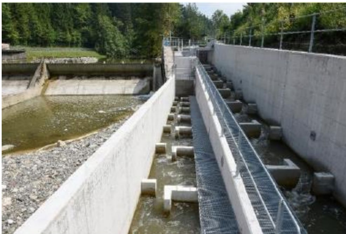
Fiskepassasje ved Hüttener Wehr i elven Sihl, Zürich kanton - Sveits. Foto: A. Springer
