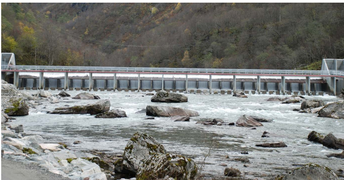
Figur 2. Fiskesperre i Driva er en absolutt barriere (foto: Leif Lia/NTNU).
