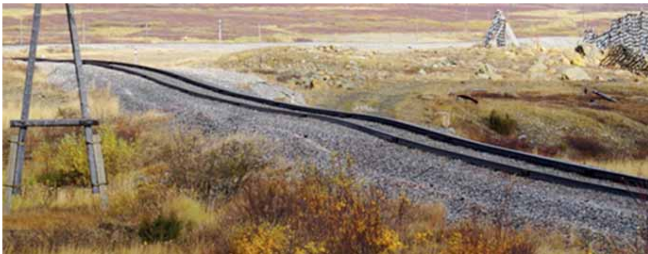
Рис. 1. Характерные просадки пути в районе исследований
