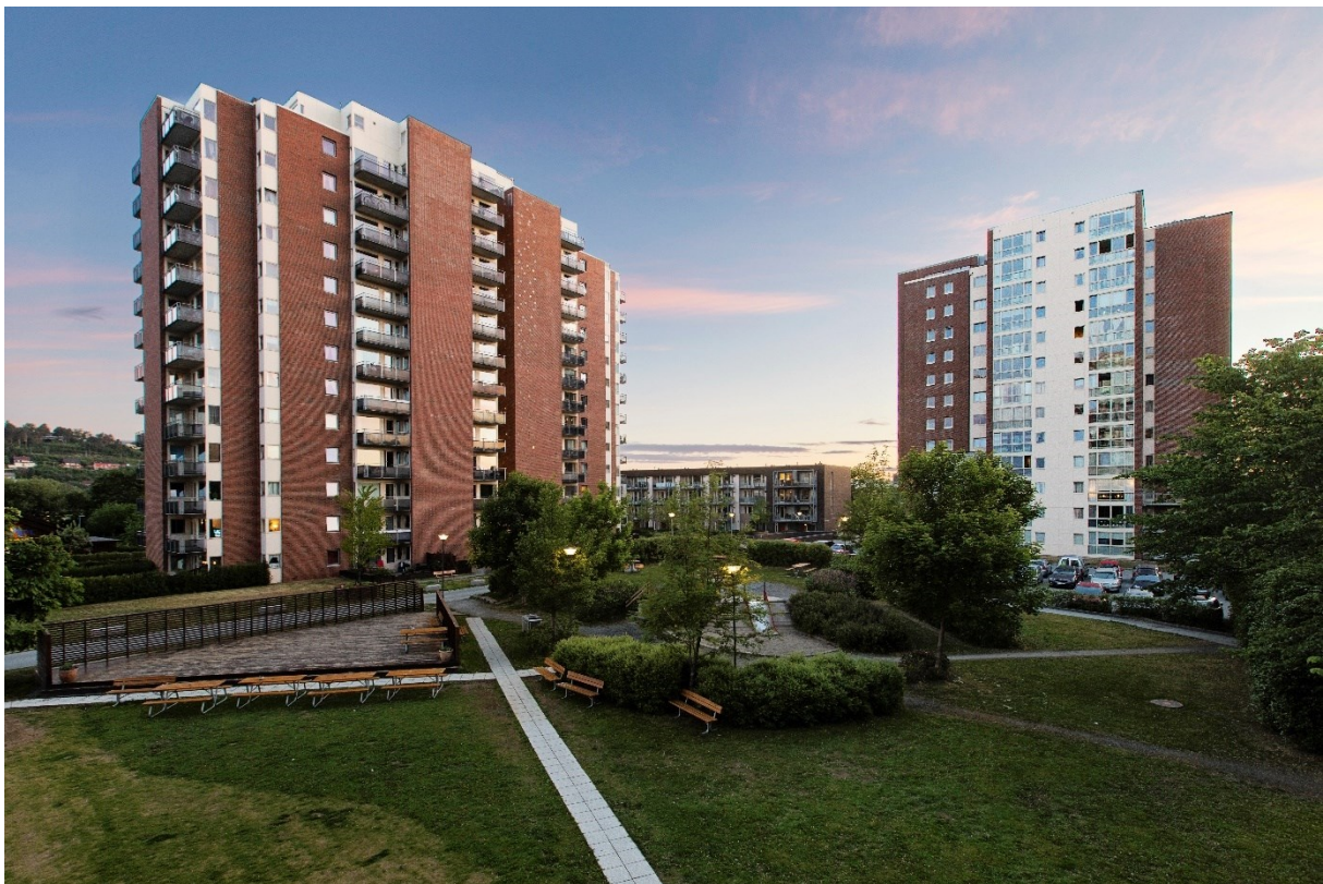
Figur 2: Bilde av Ola Frosts veg 3, 1 og 2 (fra venstre).
