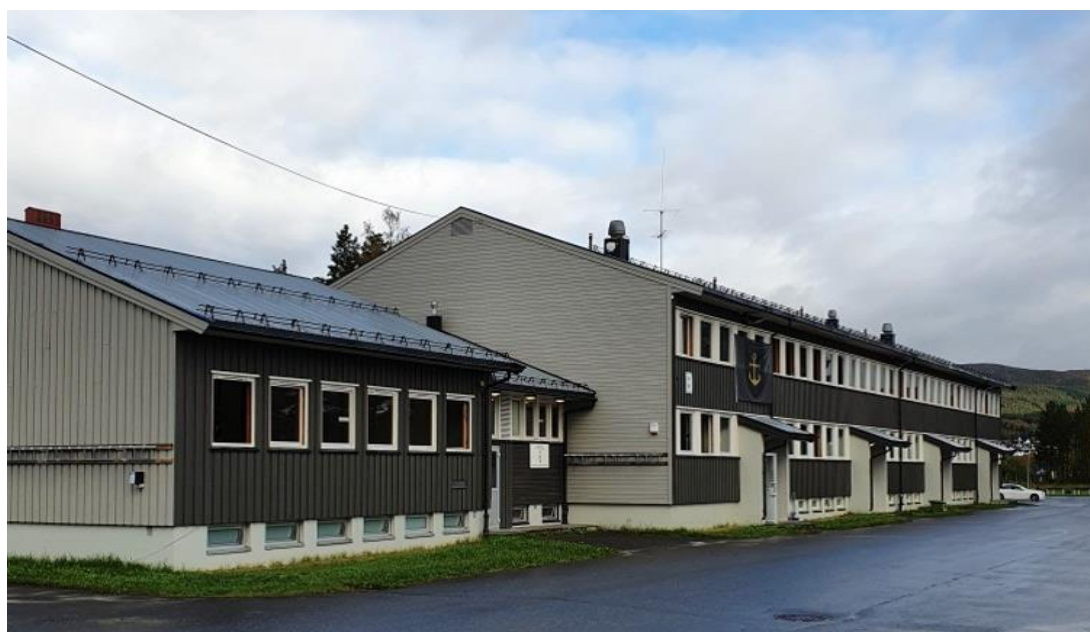
Figur 3.4: Kaserne B (Forsvarsbygg, 2022).
