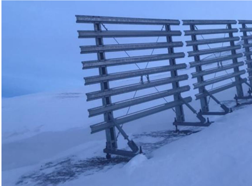
Figur 40: Bilde av snøskjermer på nordsiden av Sukkertoppen ved Longyearbyen. Bakkeklaringen ble kontrollmålt til 85 cm som tilsvarer 21 % av den totale skjermhøyden på 4 meter (Jonsson et al., 2018). Foto: Vetle Basma.
