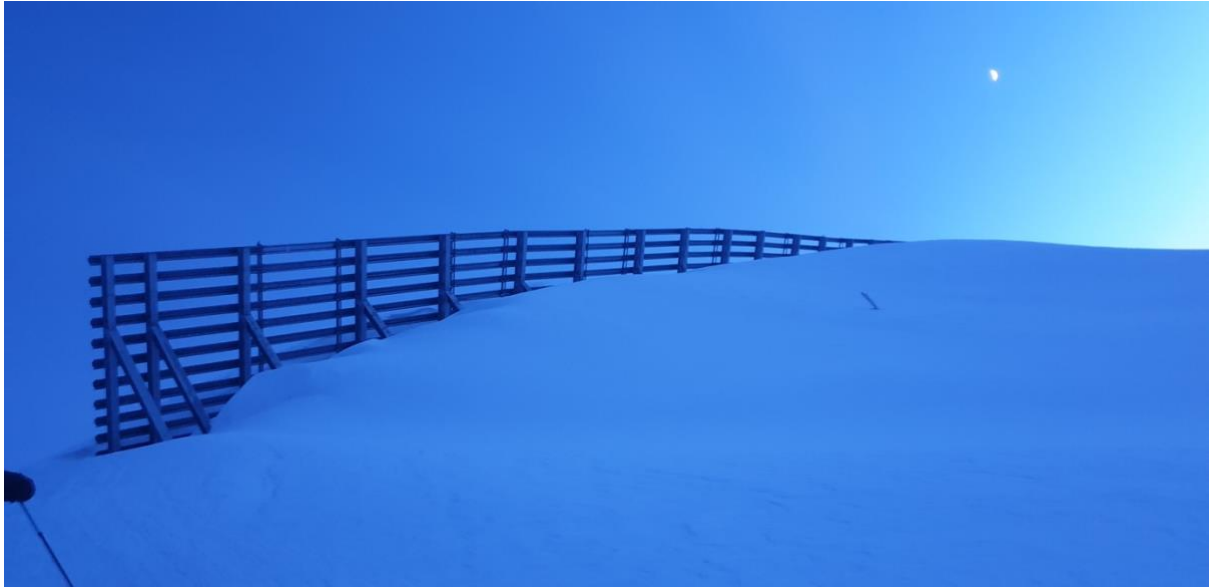
Figur 78: Snøakkumulasjon bak øverste støtteforbygning på Sukkertoppen. Foto: Philip Kunz.
