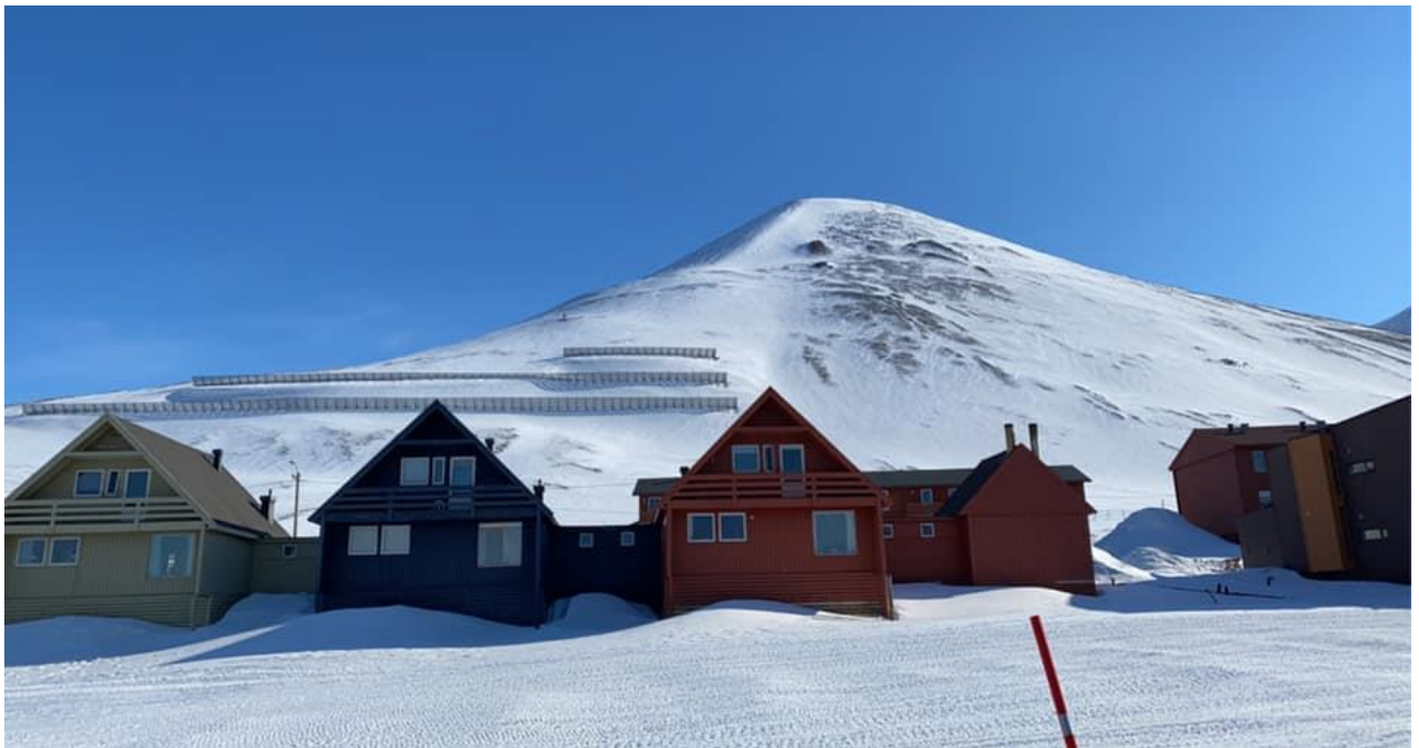
Figur 25: Tre rader med støtteforbygninger montert på Sukkertoppen på Svalbard. I løpet av 2021 og 2022 skal 15 nye rader med støtteforbygninger monteres til høyre for eksisterende konstruksjoner. Foto er hentet fra: (DS Entreprenør, 2018).
