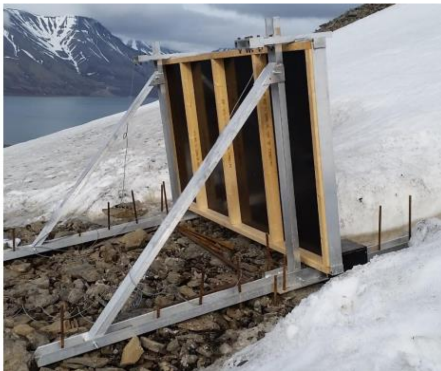
Figur 68: Forsøksveggen oppstilt ved tidligere plassering, veggen er flyttet i etterkant. Foto: Jan Are Jacobsen. Hentet fra: (Jacobsen, 2017).
