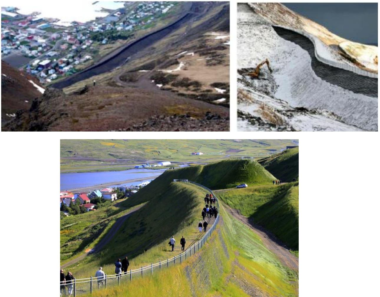
Figur 35: Fangvoll bygd med løsmasser i Siglufjörður på Island, samme fangvoll som ses på figur 33. Figuren er hentet fra: (Landslag, 2003).
