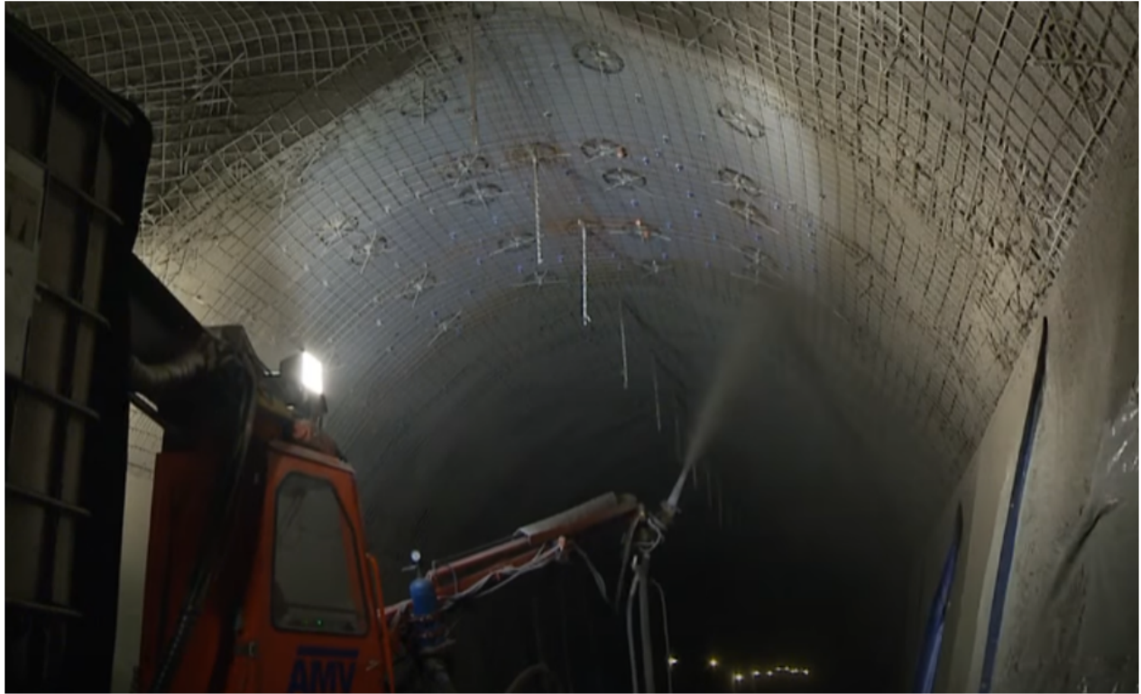
Figur 31: Påførelse av sprøytebetong. (Skanska Norge, 2014)
