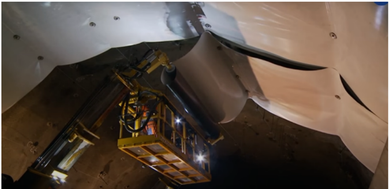
Figur 38: Montering av membran. (Skanska Norge, 2014)
