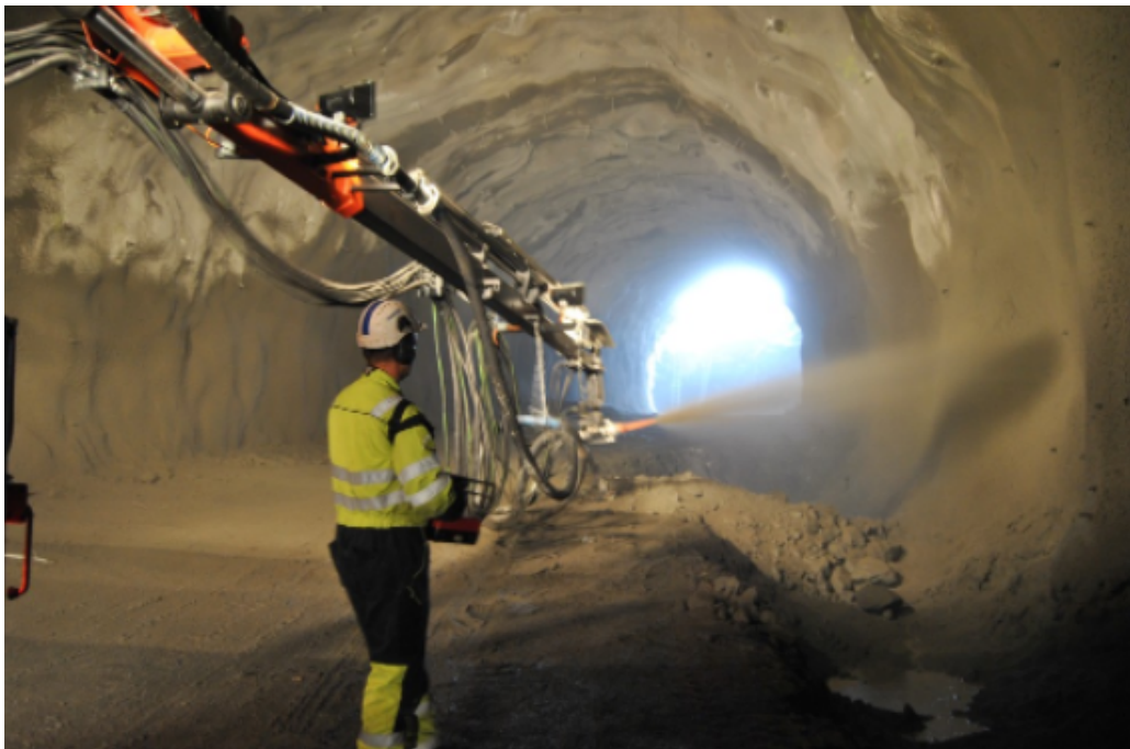
Figur 14: Påføring av sprøytebetong. (Snemyr, n.d)
