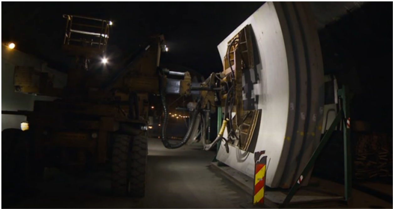
Figur 40: Elementmontasje med vakuumsflate. (Skanska Norge, 2014)
