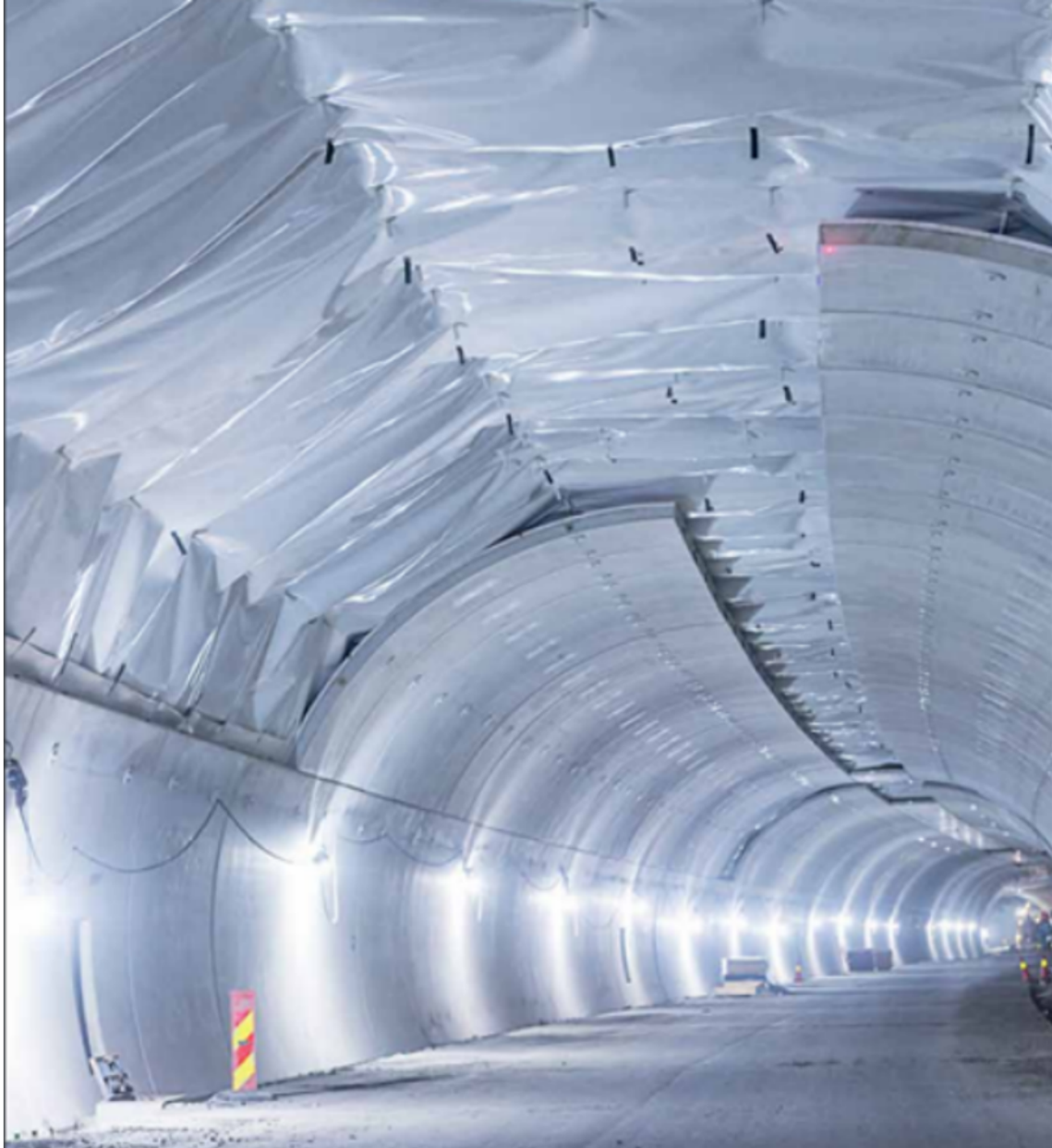
Figur 39: Utført membranmontering. (Skanska Norge, 2014)
