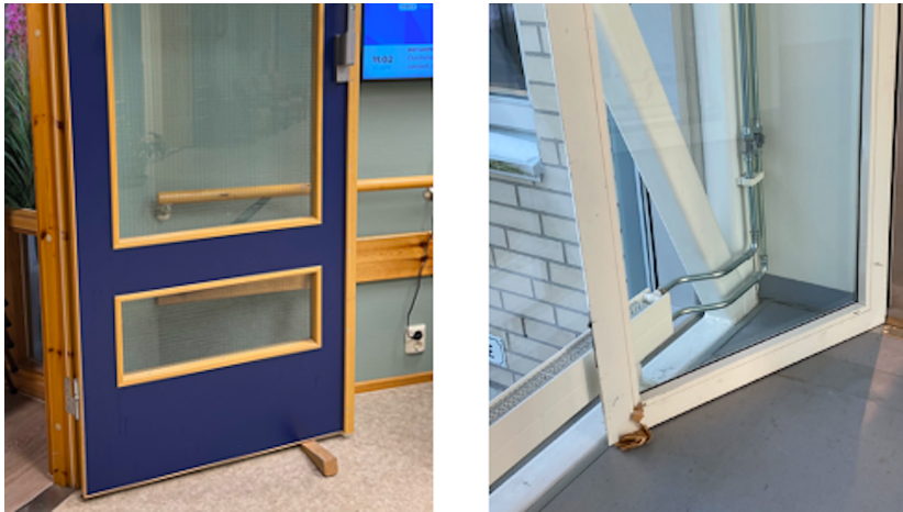
Figur 6.1: Kile under dørblad for å holde døren åpen.
