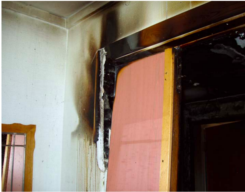
Figur 5.2: Gjennombrant mellom dørkarm og vegg i det ombygde hobbyrommet (Direktoratet for samfunnssikkerhet og beredskap, 2007).
