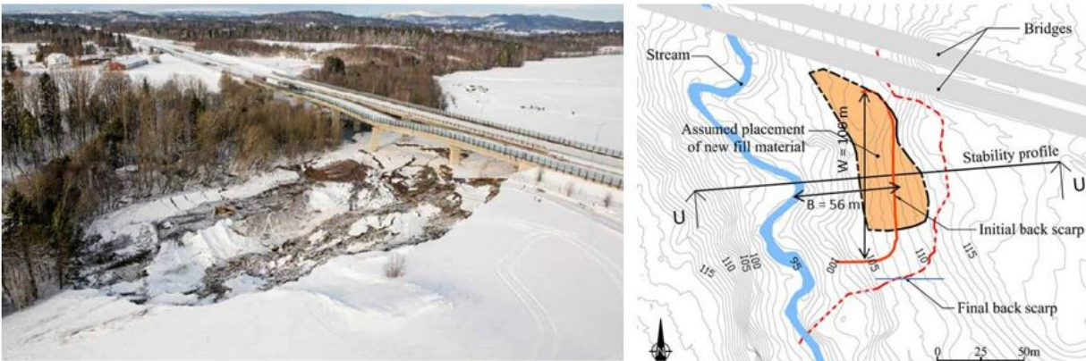
Figur 3.3: Til venstre vises terrenget etter skred. Til høyre vises terreng før skred inkludert fyllingen som ble etablert på toppen av skråningen. Rød linje angir opprinnelig skred kant. Endelig skredkant er angitt av rød stiplet linje, ref. Jostad et al. (2021).
