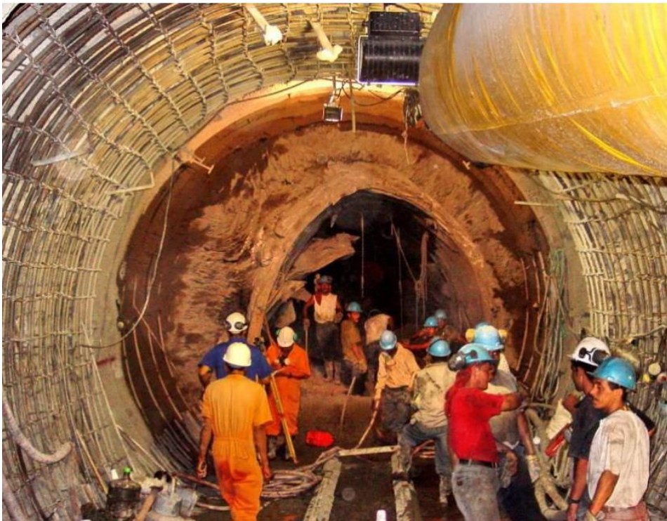
Figur 3.6. Vanntunnel i Venezuela. Tunnelen gjennomgikk omfattende skvising og tunnelversnittet ble betydelig redusert. I forgrunnen vises rehabiliteringen av tunnelen som innebar ytterligere utgraving og installering av sikring (Hoek & Marinos, 2009).
