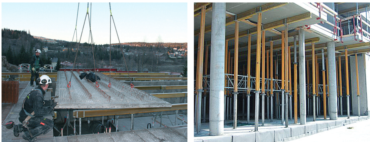
Figur 2.17: Montasje av forskalingsplater [65].
