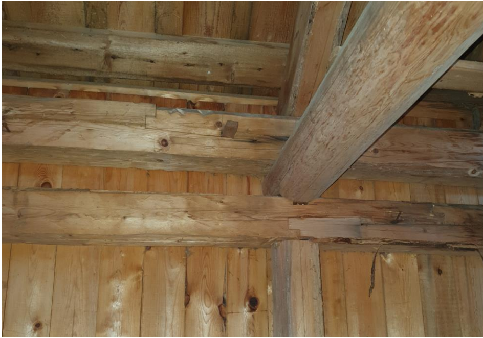
Figur 5 - Fra befaring, fransk brukt som dobbel toppsvill
