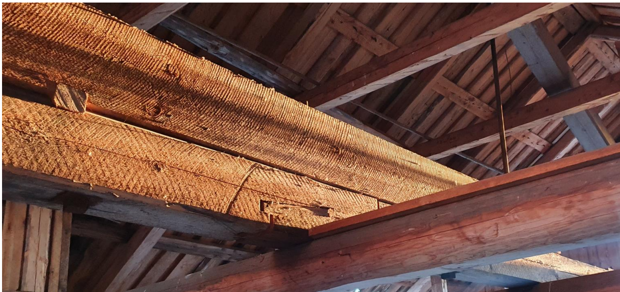
Figur 4 – Fra befaring, fransk lås som del av forsterkningsbjelke for materialløfting.
