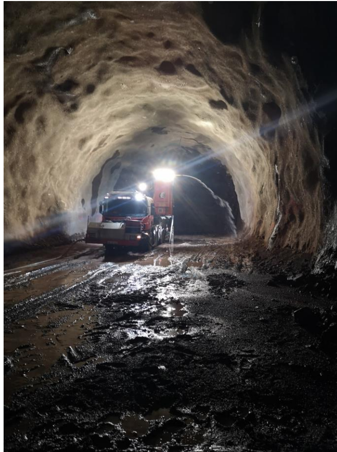
Figur 5-1: Sprøyterobot på stuff klar til vask av fjell.
