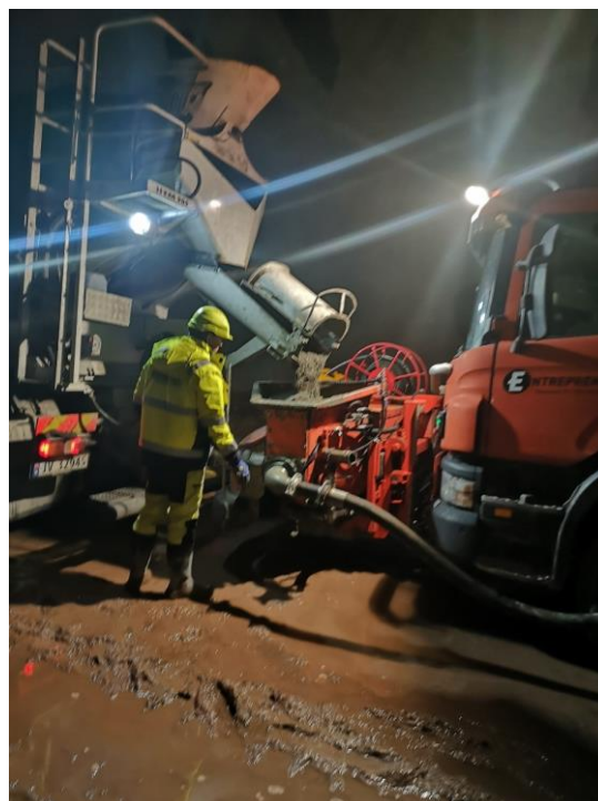
Figur 5-2: Operatør fra NorBetong kontrollerer lossing av basisbetong.
