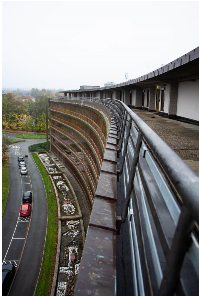
Figur 25: Bekkeløpet langs NVE-byggets fasade. Tørrlagt etter sommersesongen. Foto: Håkon Viksmo Lie
