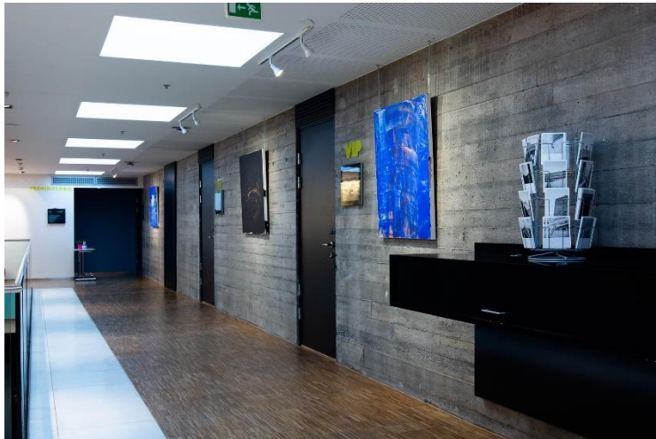
Figur 7: Eksempel på béton brut-aktig betong i Viksjøs arkitektur – vel og merke uten komplekse forskalingsmønstre. Fra administrasjonsbygget til Standard Telefon og Kabelfabrikk A/S. Foto: Håkon Viksmo Lie.
