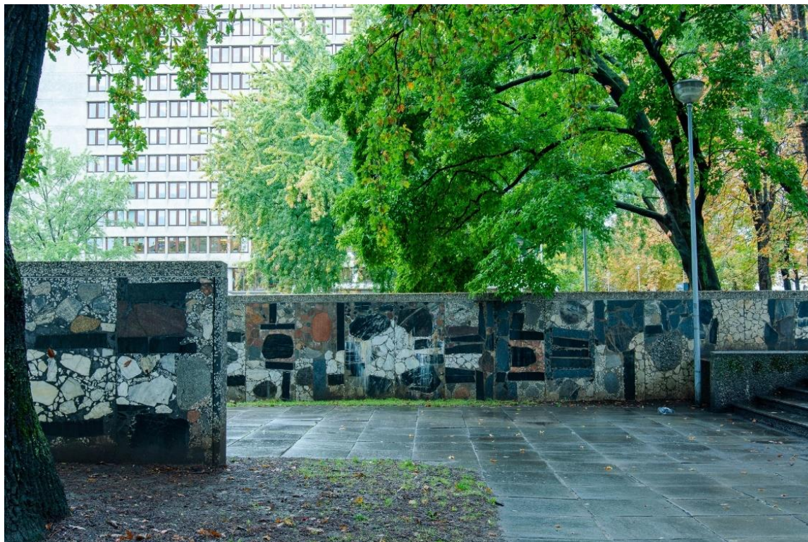
Figur 3: Murer i conglobetong fra Hydroparken. Foto: Håkon Viksmo Lie
