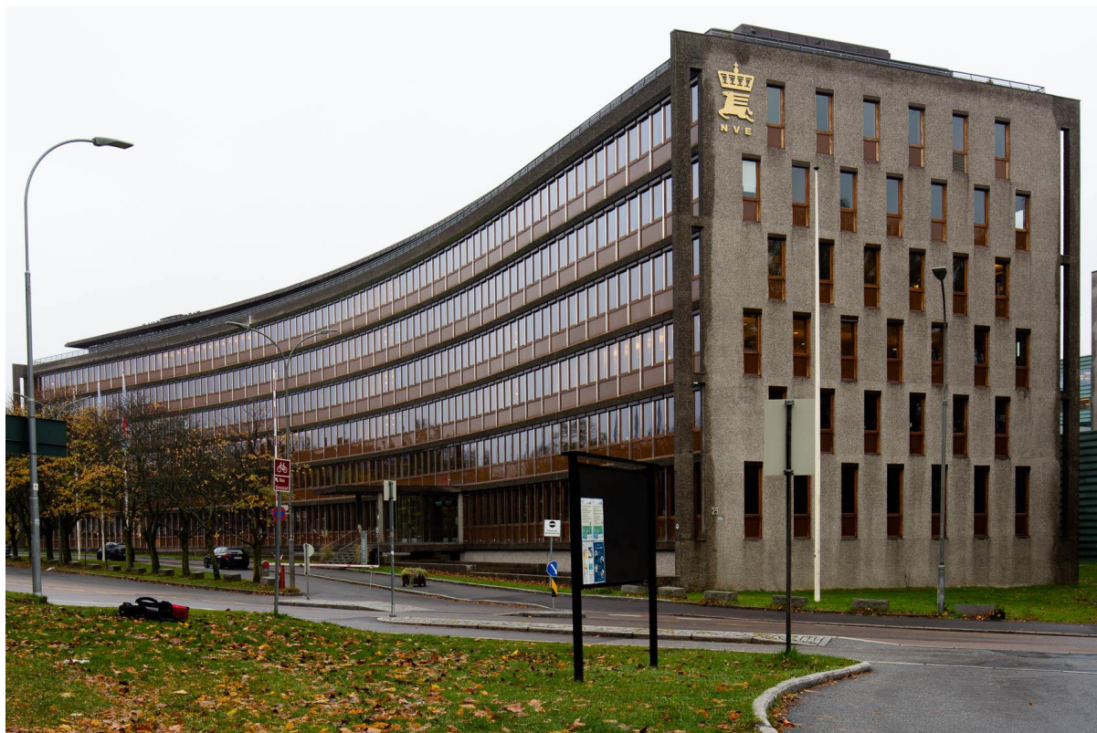
Figur 24: NVE-byggets to hovedfasade. Foto: Håkon Viksmo Lie
