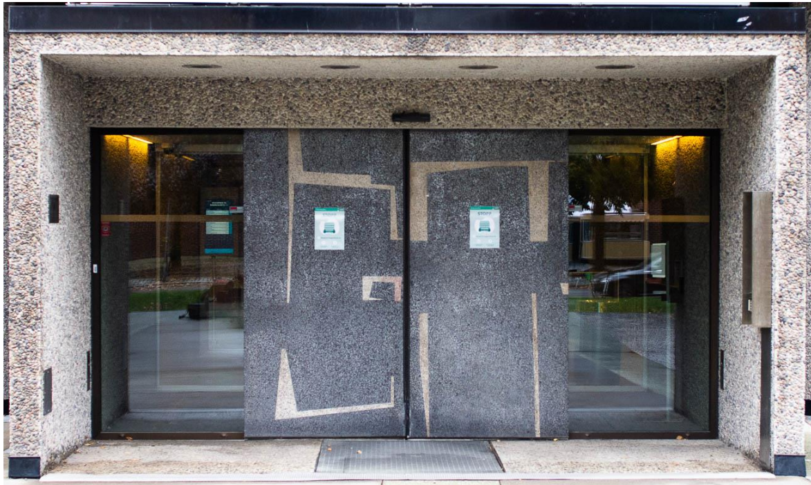
Figur 2: Dører i metallbetong fra Elkem-bygget. Foto: Håkon Viksmo Lie
