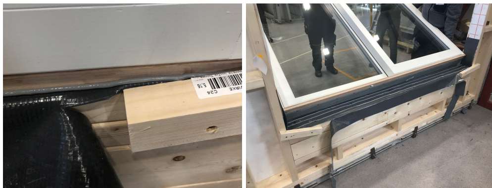
Figur 3.17: Fugemasse presset ut som følge av innsetting av dør og påfølgende justering av plassering i veggliv. Intakte fugestrenger før innsetting vises til høyre.
