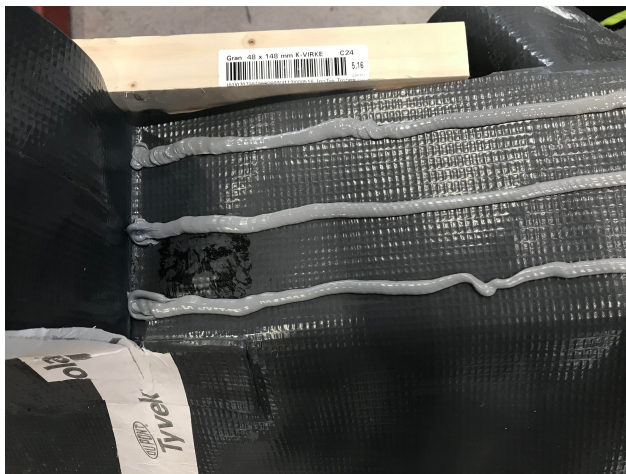
Figur 3.16: Fugestrenger under terskel av varierende tykkelse.
