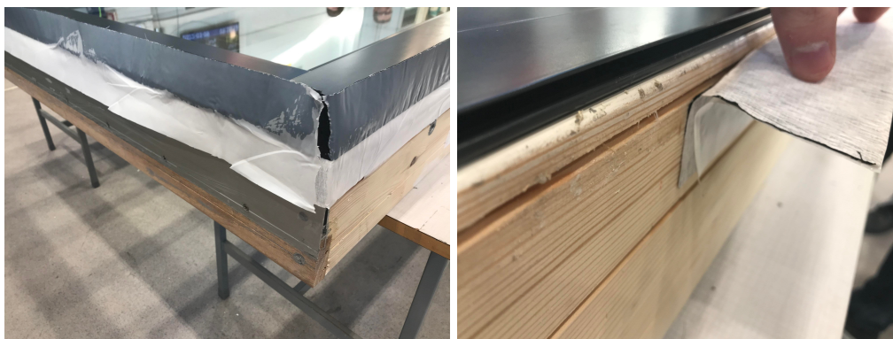
Figur 3.22: Skyvedør lagt ned i arbeidshøyde for å tilrettelegge for montering. FlexTett påført innenfor dreneringsspor.
