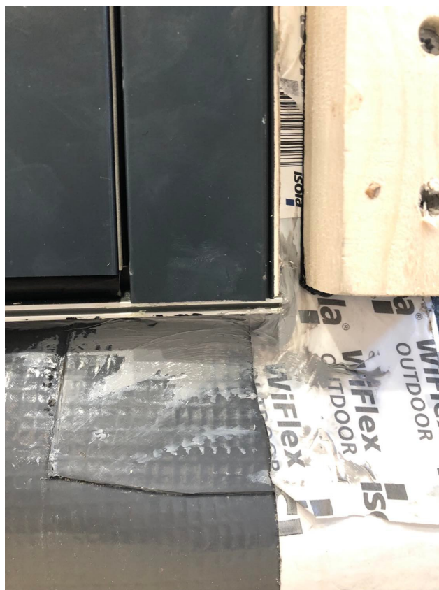
Figur 3.19: Fugemasse og tape i hjørne.
