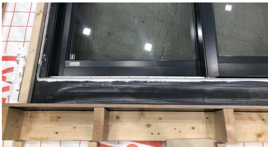
Figur 3.31: Fugemasse påført foran tettelist i Forsøk 5.
