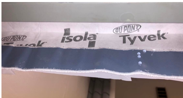
Figur 4.16: Vanndråper renner fritt gjennom overgangen mellom FlexTett og vindsperretape.
