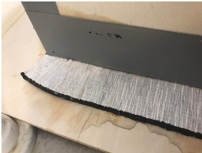
Figur 4.18: FlexTett løsnet i hjørnet som følge av vannpåkjenning under testing mot kryssfinér.
