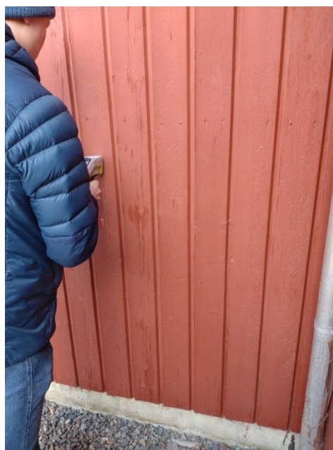
Figur 8 – Skanning av kledning fra 1980
