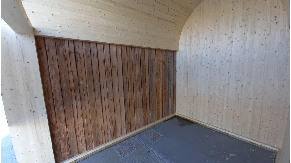
Vedlegg 13: Vegg der utsparinger fra det opprinnelige bygget fremdeles kan sees, Norsk Massivtre.
