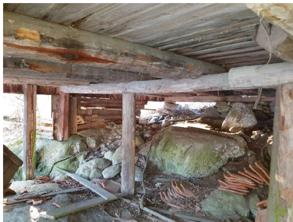
Figur 12: Bærende konstruksjon under gulv (Foto: Privat)
