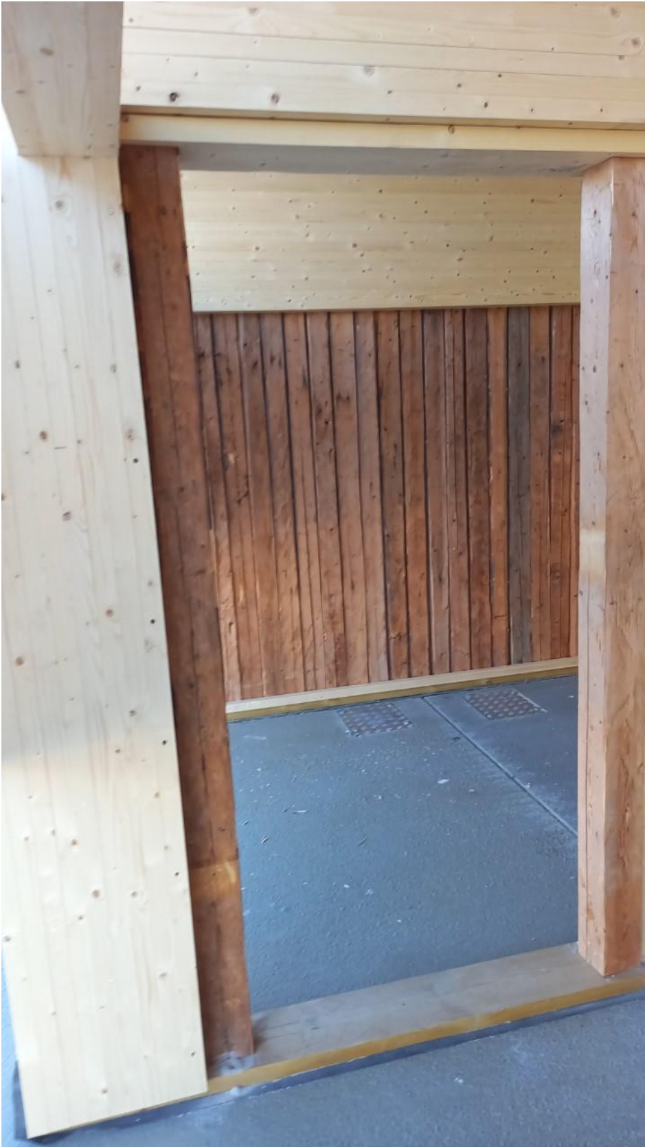
Vedlegg 14: Kombinasjon mellom gammelt og nytt i badstue fra Norsk Massivtre
