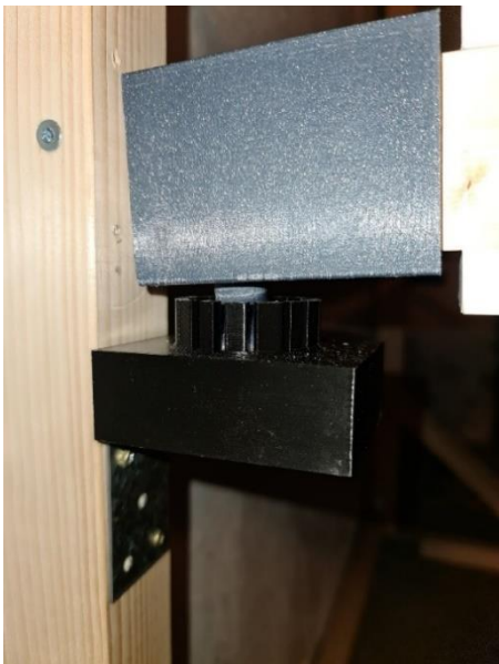
Figur 90: Nærbilde av kulekobling montert på balkong.
