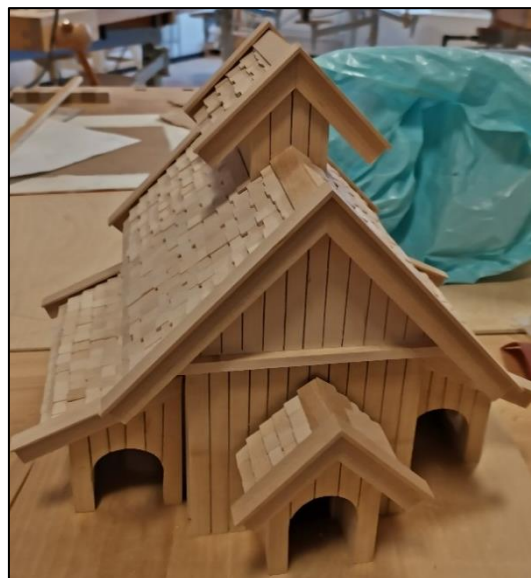
Bilde 4.15 – Ferdigstilt tak med spont, vindski og møneplank
