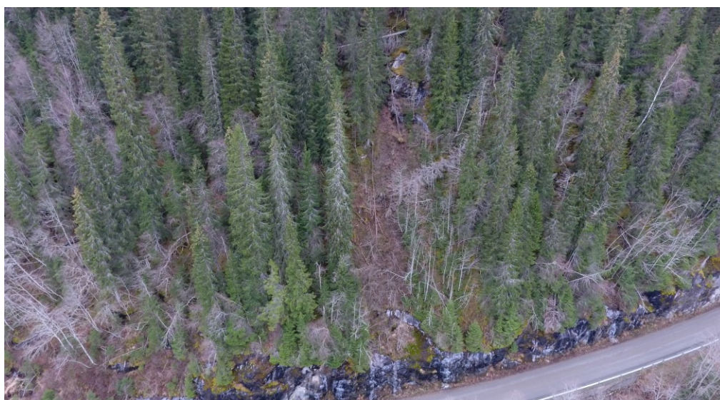
Figur 6.5: Skredbane ned mot Fv631 i Troøybakkene ovenfor Kotsøy. Skredbanen kan sees midt i bildet. Fotografert med drone av Sverre Dælhi.
