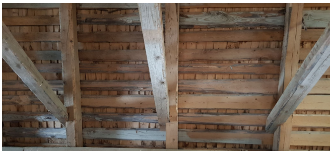
Fig.16 Våningshuset på Storhagen, Lillehammer, 52/14 Foto Jørn Ulven
