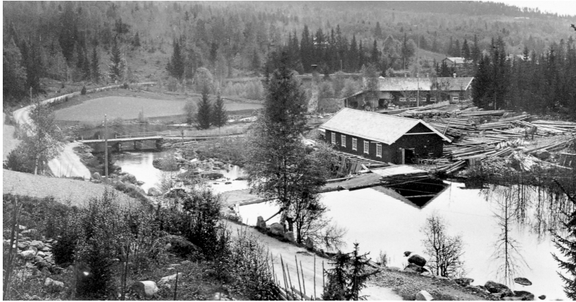
Fig. 26 Foto Normann 1920, Taket på våningshuset til Myrvold synes helt øverst til høyre.
