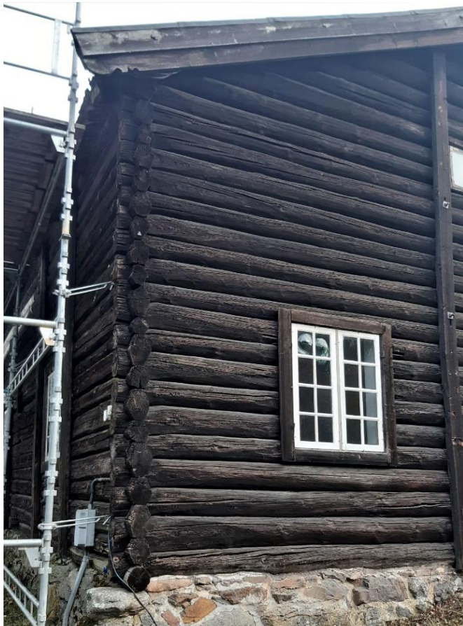
34. Vestre hjørne på Molstadkvernbygningen (Foto: Høgnes)
