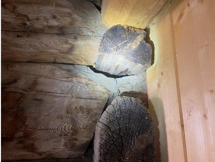
4. Halve novskallen manglar, og ein kan studere oppsåta. (ref.bygg Aabol) (Foto:Aabol)
