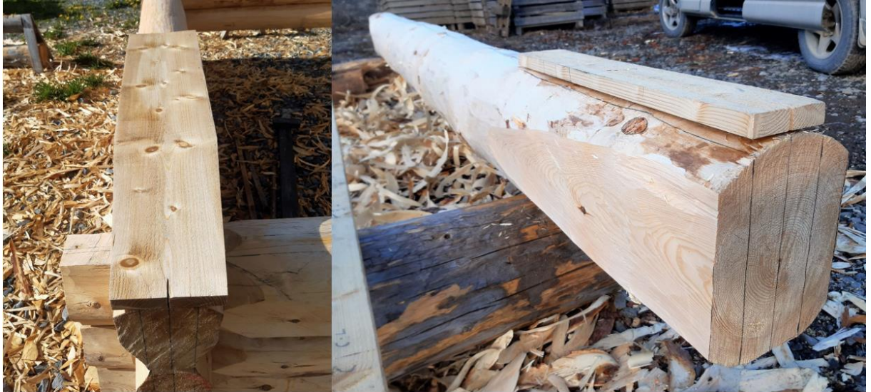
52 og 53. Maler lagt på for å vise hvordan de blir lagt for merkinga for halsinga på sidene og flata på ryggen. (Foto: Høgnes)
