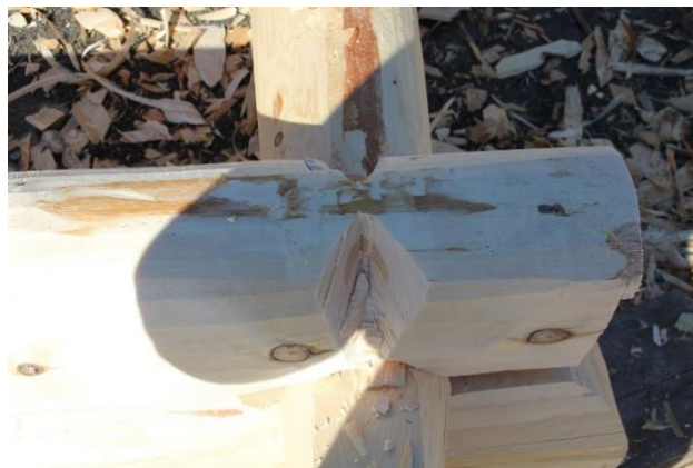
87. Fyrste innhogget for å komme så langt inn som kinningane skal gå. (Foto: Selsjord)
