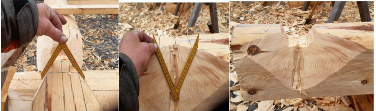
58, 59 og 60. Oppmåling og uthogging av "postordrelaft".(Foto;Høgnes)
