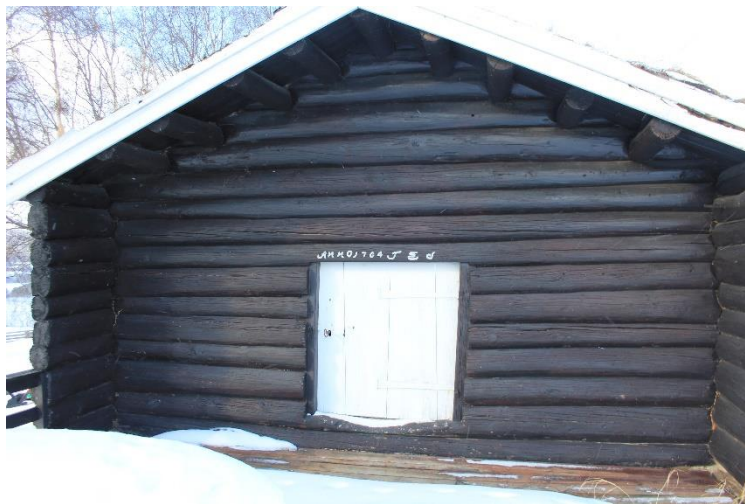
67. Eit eksempel på eit liknande stabbur som referansebygget som er nytta i oppgåva. (Foto: Selsjord)
