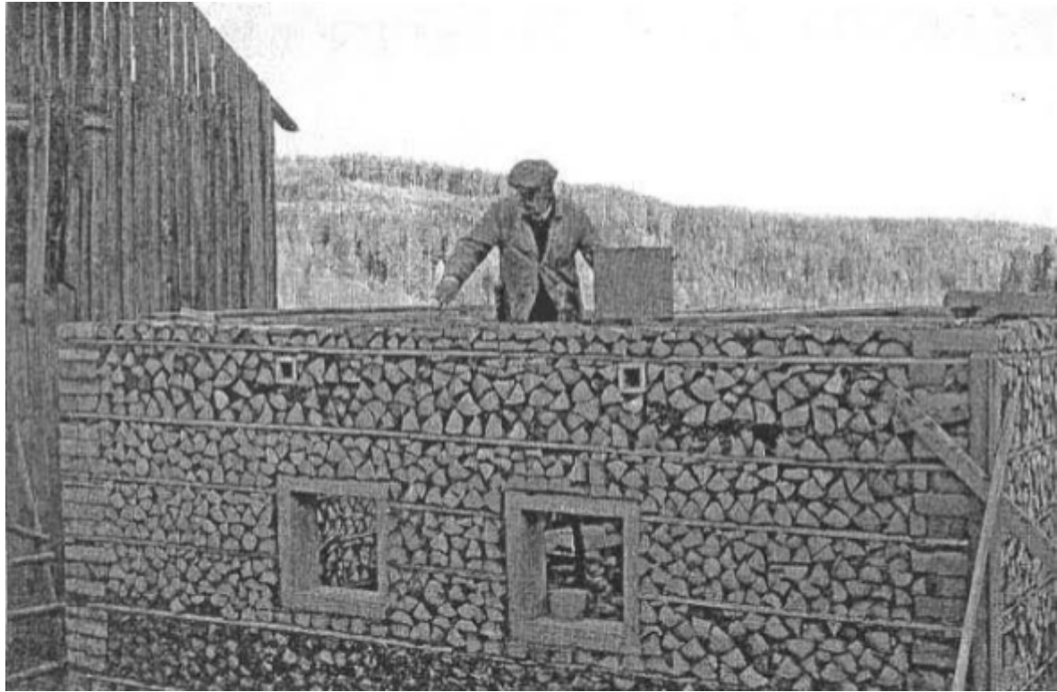
Rekonstruksjon av kubbefjøset på Langsrud i Eidsvoll i 1980-81 Foto av Jorunn Engen
