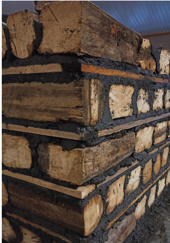
Krysslagt hjørne Foto av Preben Nilsen
