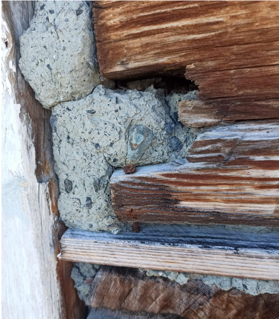
Innfesting av endekubbe som er fylt med leire
