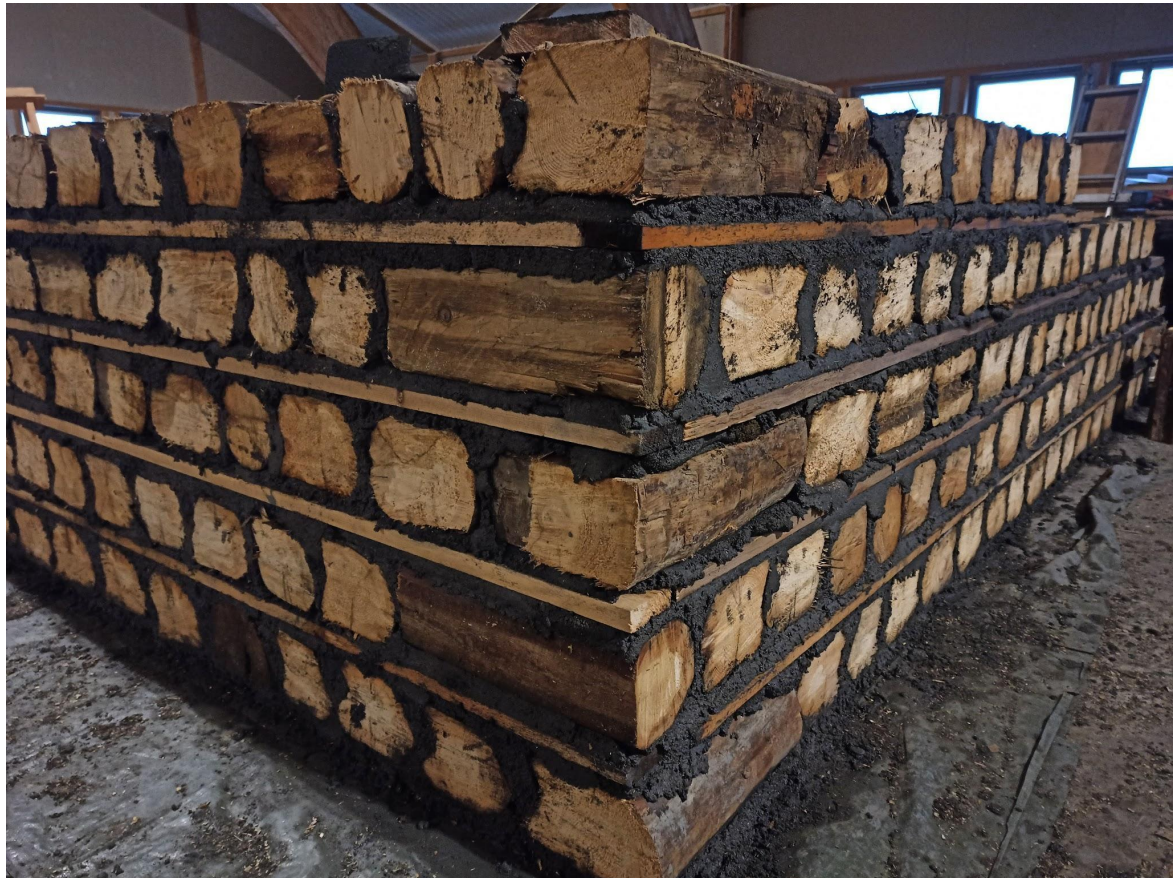
Ferdig murt kubbevegg
