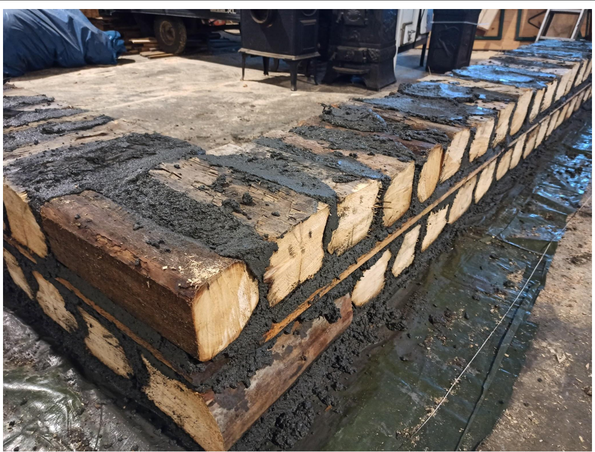
Krysslagte kubber ferdig murt
