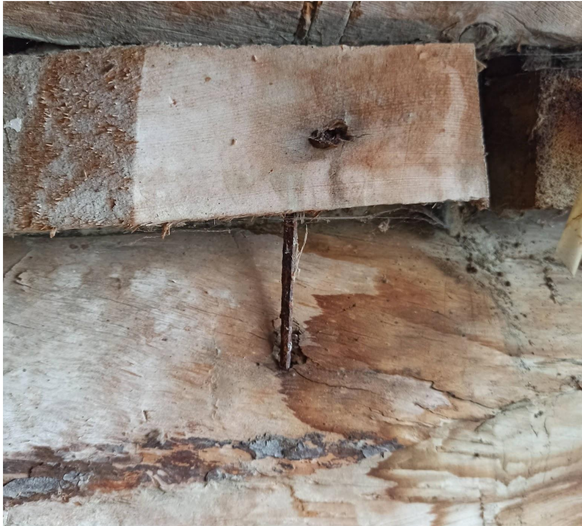
Innfesting av horisontale avstivere i vindusåpning
