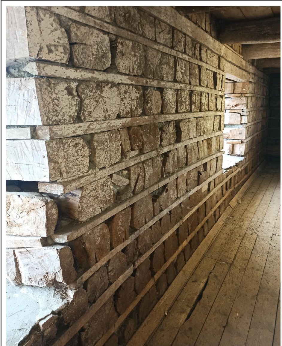
Kubbevegg mellom to vindusåpninger
