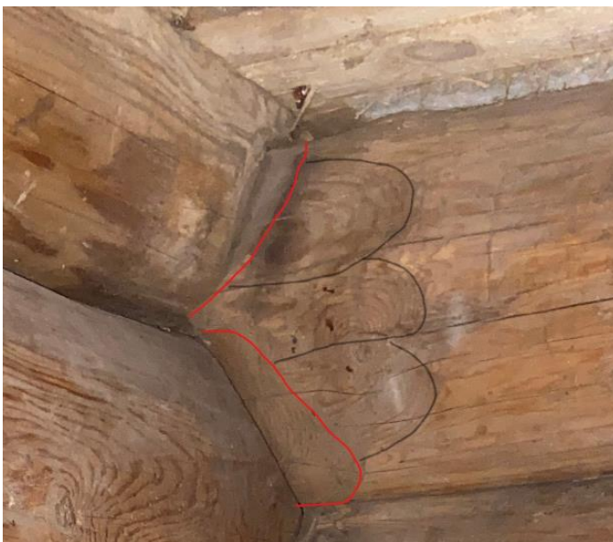
17. Halsing med svart strek, kinning merka raud. Stølbu, Bø i Telemark. (Foto: Aabol)
