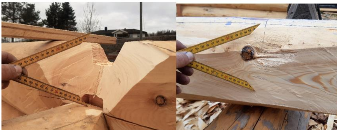
56 og 57. Måle opp kinningane og hogge dei, før stokken skal opp i veggen. (Foto; Høgnes)
