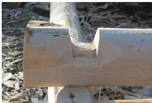
98. Ferdig grovhogge nedlaft. (Foto: Selsjord)
