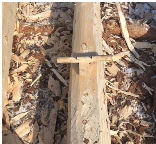
86. Skave bort øksespora på stokken med pjål/skjøve før den skal inn i vegg. (Foto: Selsjord)
