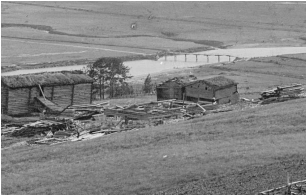
82. Bilete syner tømringa av våningshuset på Hovauk. her kan ein sjå at dei er kome til 4 omfar. to personar står å tømmer mens to personar står å truleg og arbeidar med tømmeret (Rekstad j. 1897).
