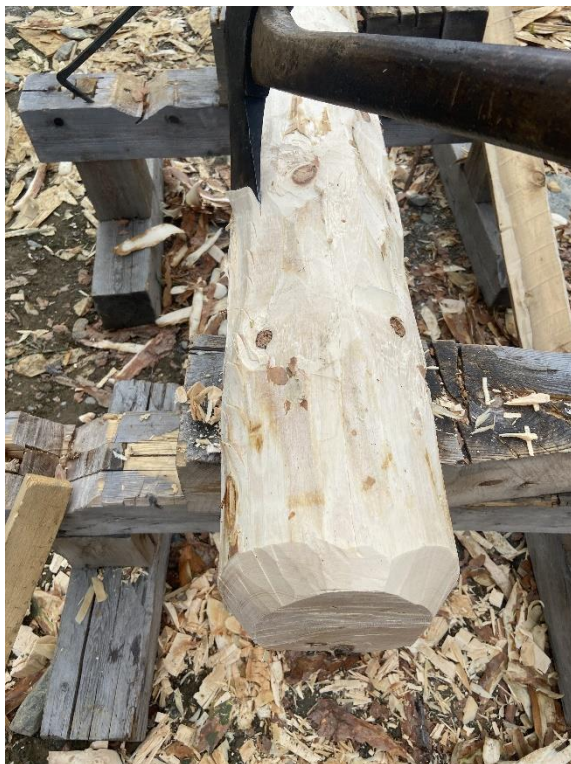
23. Halsing og forming av novskalle. (Foto: Aabol)
