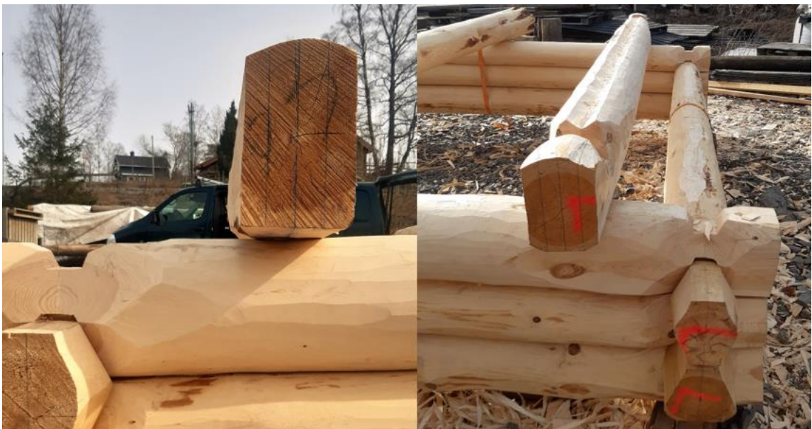
63 og 64. Flatinga på ryggen gjør at stokken ligger stødig når den er snudd rundt og ein skal hogge ut i laft og médrag. Når den blir skjøve inn kan en bruke stokken under som stillas når en hogger médraget også. (foto;Høgnes)
