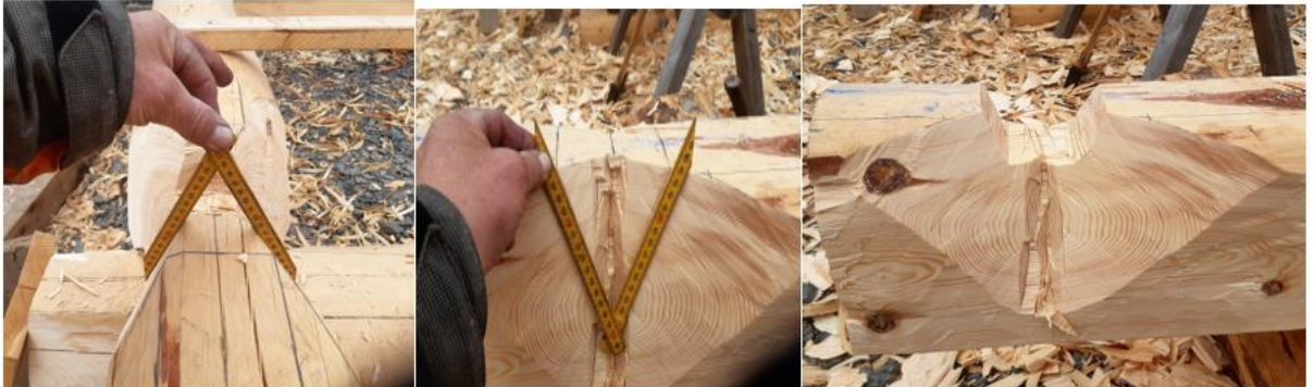
58, 59 og 60. Oppmåling og uthogging av "postordrelaft".(Foto;Høgnes)
