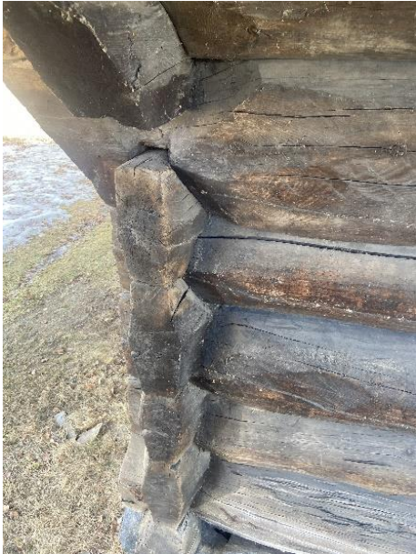
9. Nordgavl på Handeloftet, rundtømmer med halsing. (Foto: Aabol)
