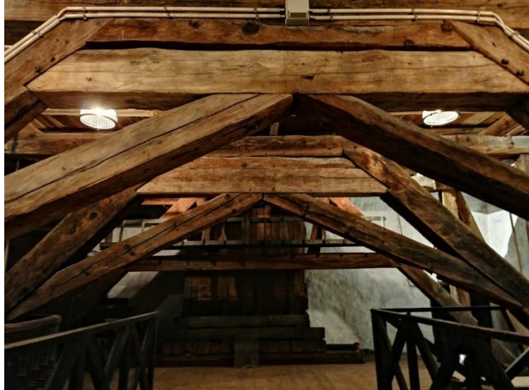
Bilde 6 3 stk. "sprengverk" som støtter seg på ringmuren av tårnet og bærer klokkestolen. (Foto, Lars Sonnenrein)
