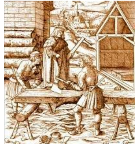
Bilde 21 Avbindningsplass rund 1500tallet, byggmesterne og tømrrersvenner i arbeid, tresnitt 1516
