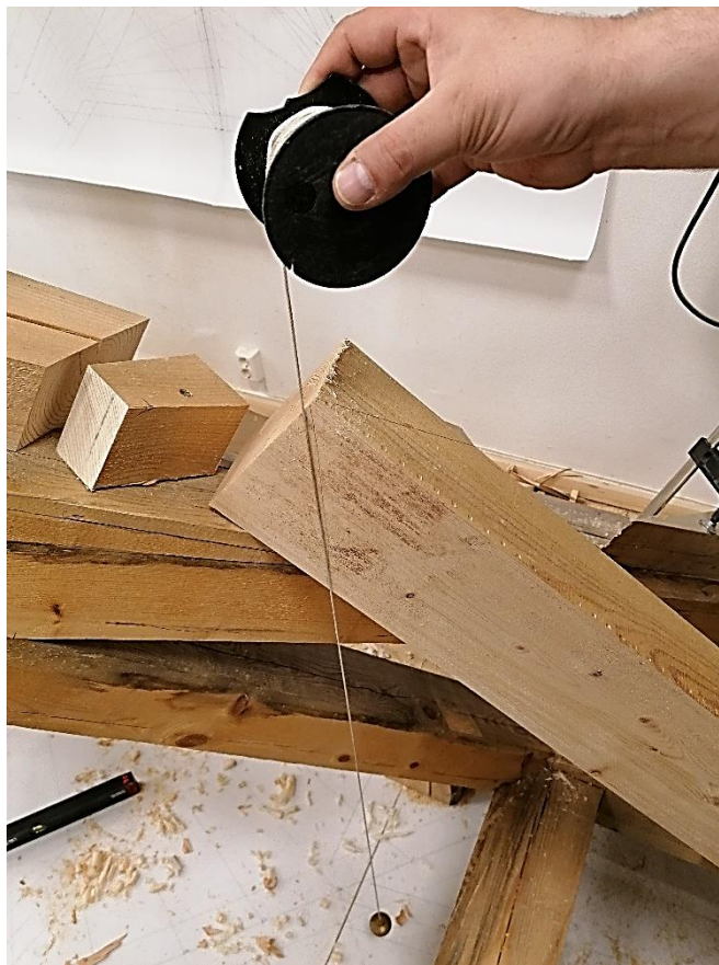
Bilde 61 Merking av loddsmygen på skiftesperren, Foto Lars Sonnenrein
