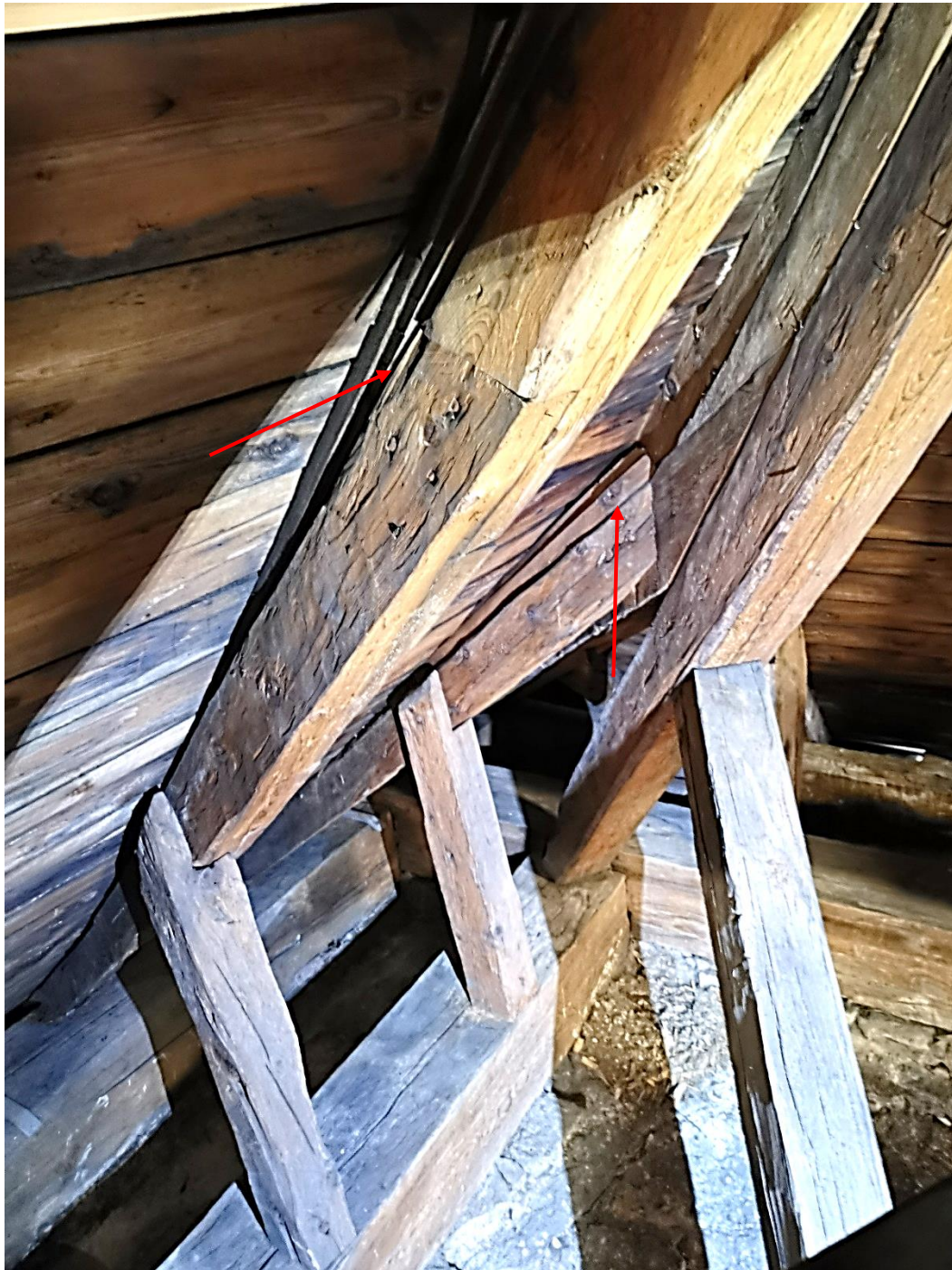
Bilde 64 Killing og oppbygging med strø i tårnet. Foto Helge Kleemann
