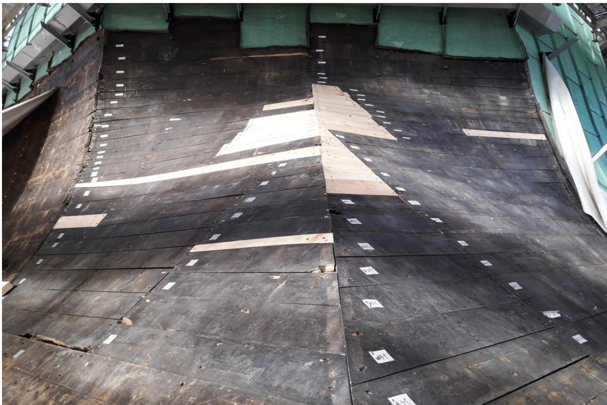
Bilde 18 Vridning fra takfoten til åttekanten. Foto Akasia
