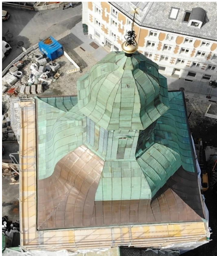
Bilde 5 Dronebilde fra tårntaket etter ferdigstilt restaurering i 2018, Bildet: BOV
