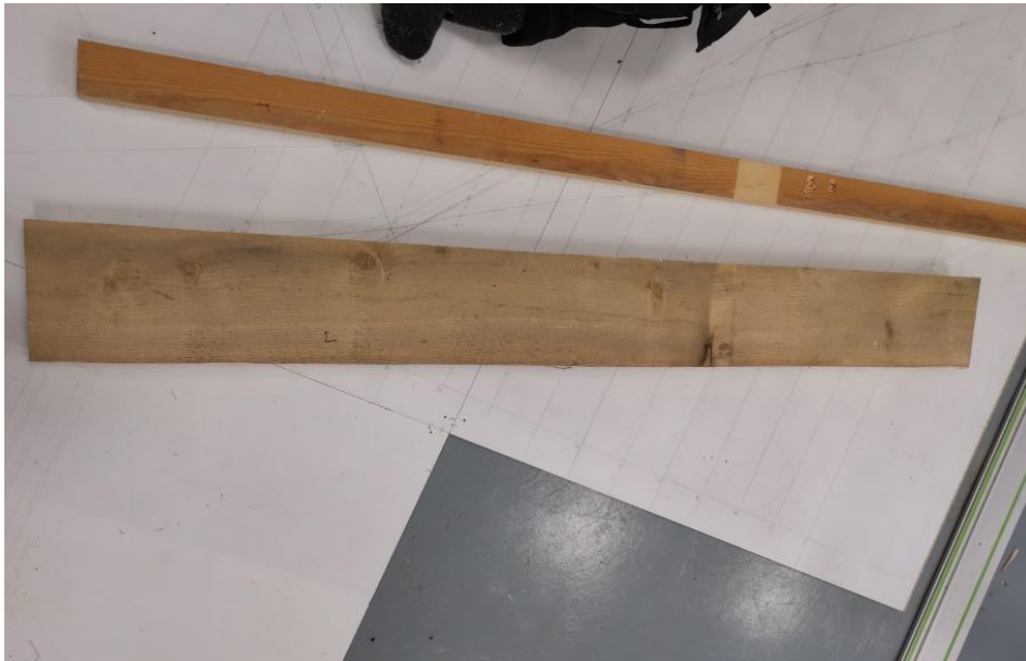
Bilde 45 Materialet lagt på profiltegningen på oppslagsgulvet. Her kan start- og endepunkt bestemmes og høydelinjene markeres. Det kan også overprøves om emne er egnet. Foto Helge Kleemann
