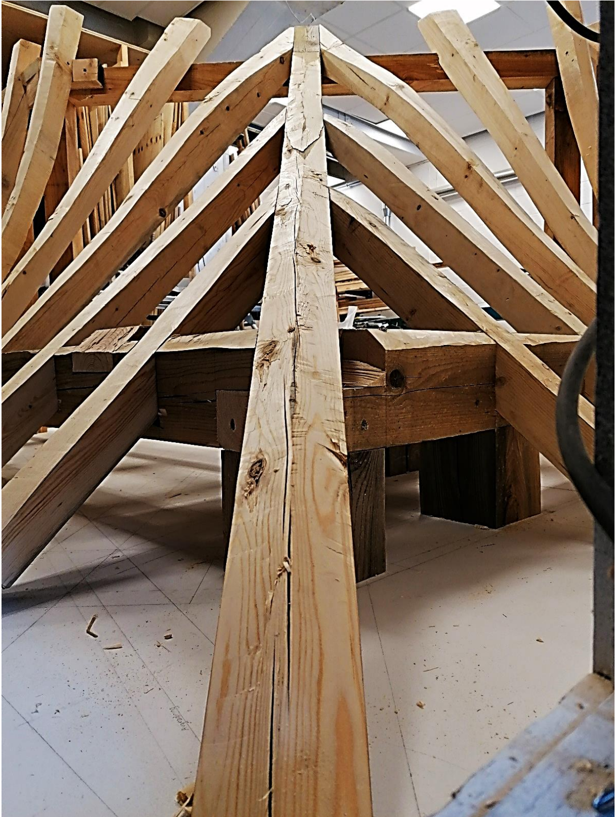
Bilde 59 Den ferdige modellen. En kan legge merke til at avkantingen på gradsperren blir mindre opp mot åsen og danner en rett linje når den treffer takflaten i åttekanten. Foto Helge Kleemann
