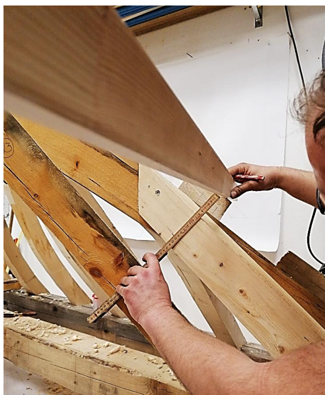
Bildet 62 Overføring av avstandsmålene i takflaten. Rettholten ligger på klossene, Foto Lars Sonnenrein
