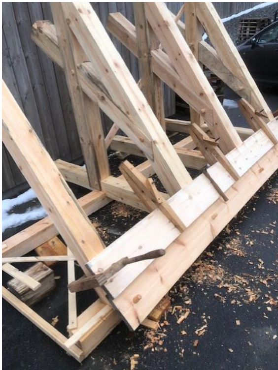
Figur 85 Båttvinger held bordet på plass. Navarbitt og skeinavar
