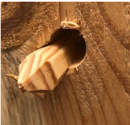
Figur 87 Åttetalshol ved oppattboring.
