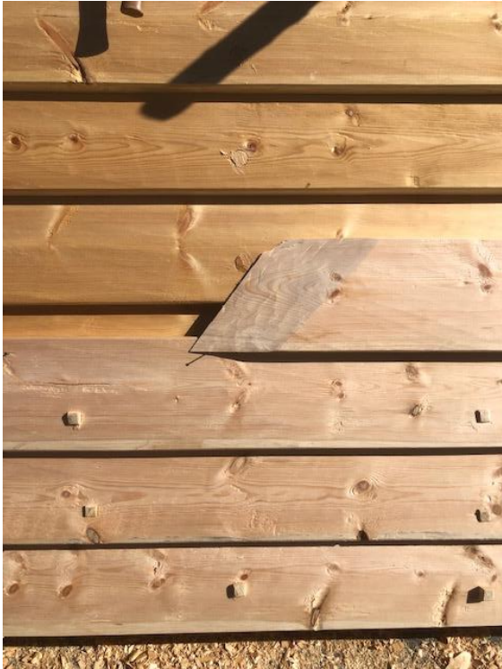
Figur 93 Lag nr to med skaring
