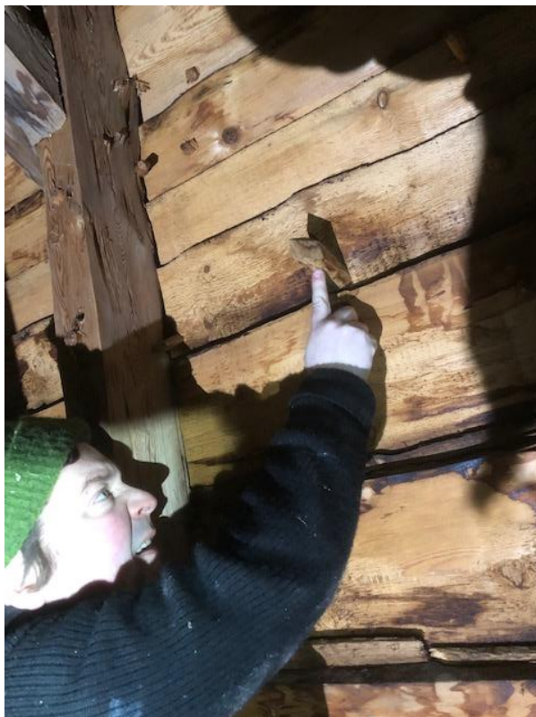
Figur 91 Nagle som kjem inn omtrent vannrett gjennom troet
