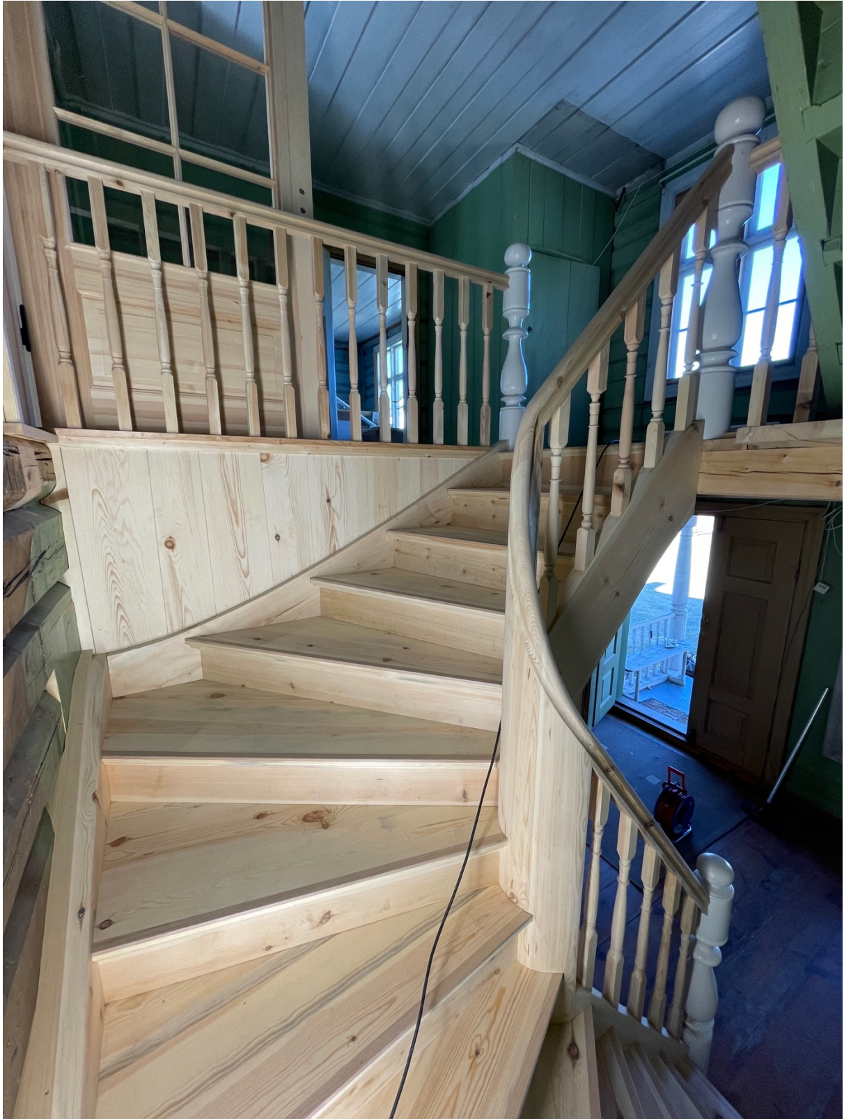
Figur 20. Midtdelen av trappa samt svingstykke.
