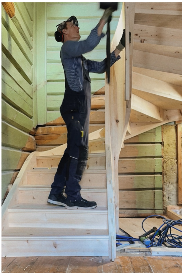
Figur 17. Montering av øvre frivange og justering med slegge.
