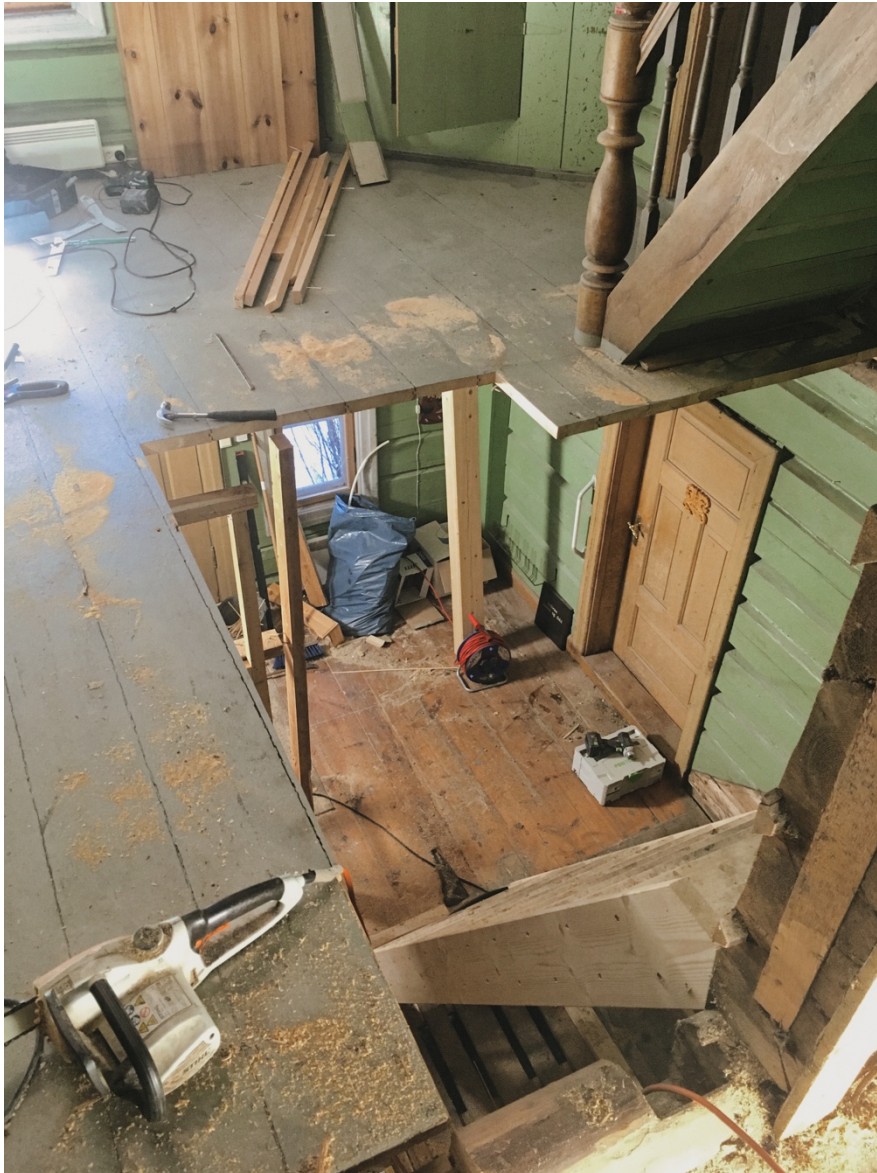
Figur 7. Utviding av trappeåpning i 2.etasje.
