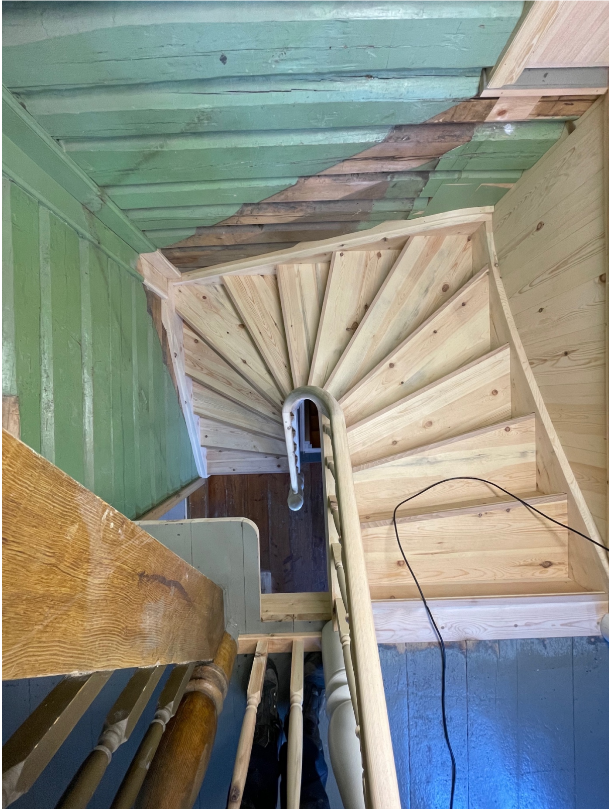
Figur 21. Hele trappa sett ovenfra.
