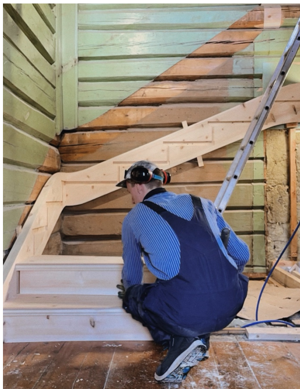
Figur 16. Ferdig monterte veggvanger og starten av montering av trinnene.
