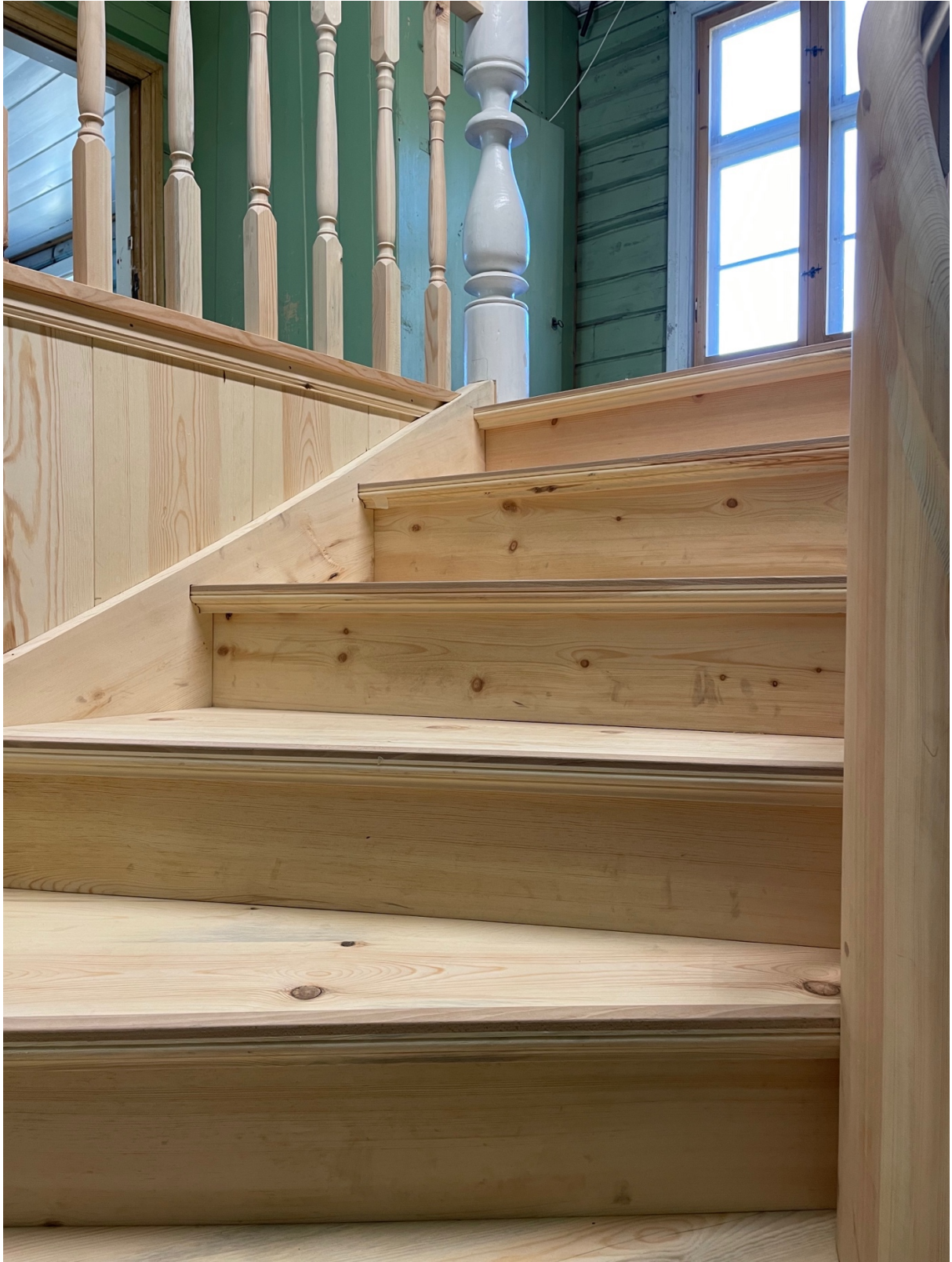
Figur 23. Øvre del av trappa samt baluster ved trappeåpning.
