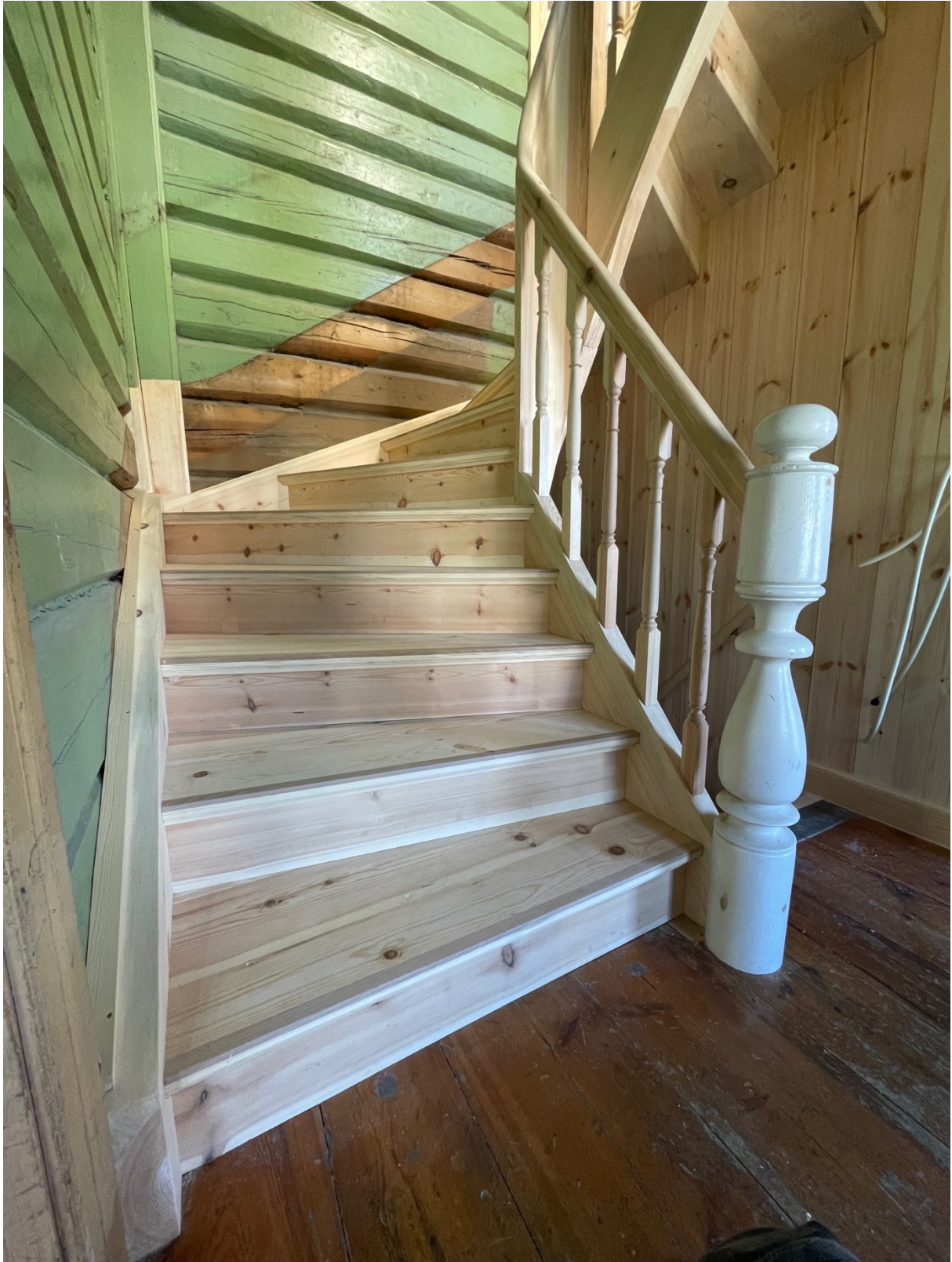
Figur 19. Første trinn av trappa samt nedre håndløp og baluster.
