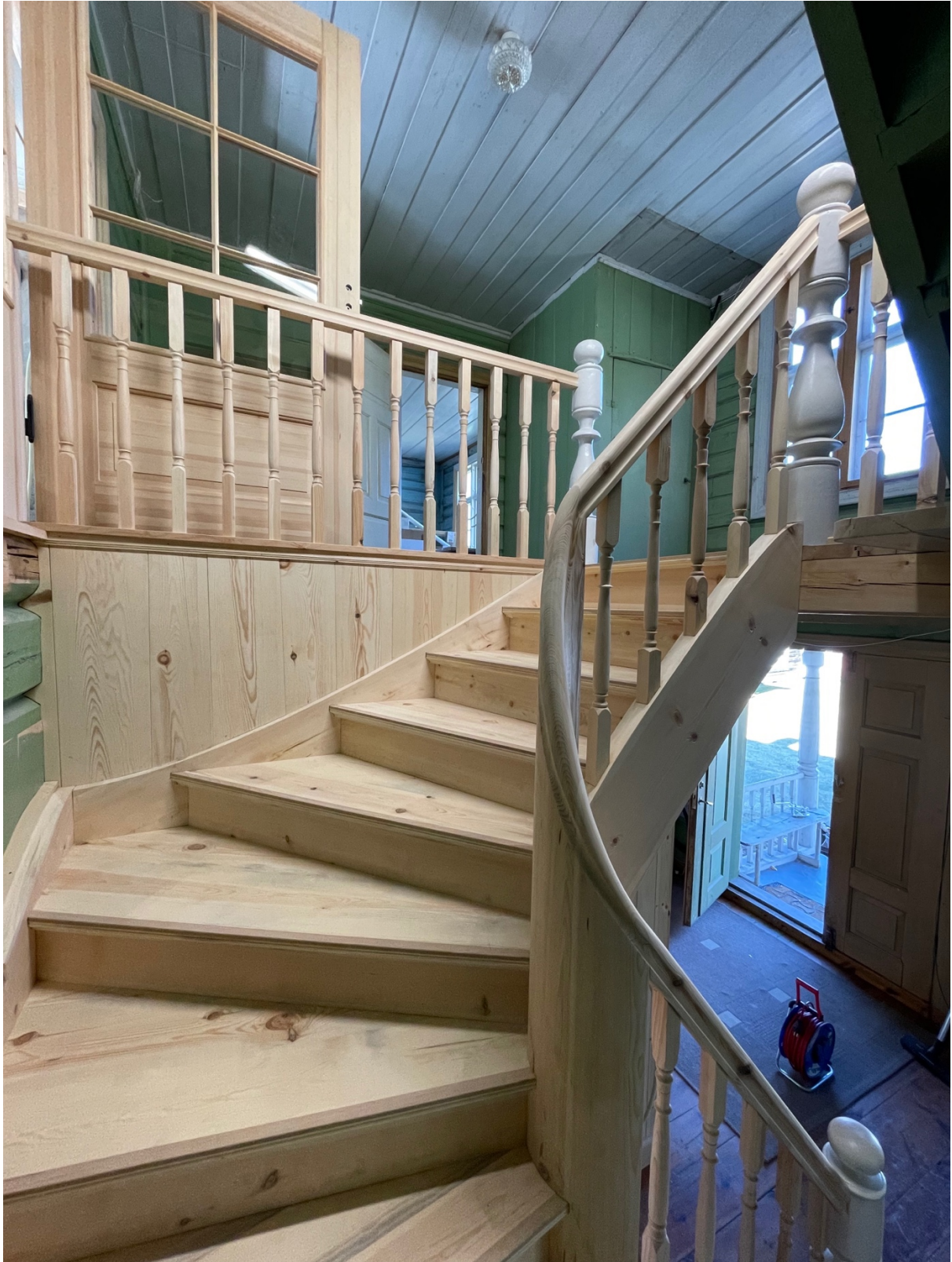
Figur 26. Baluster ved trappeåpning samt øvre del av trappa.
