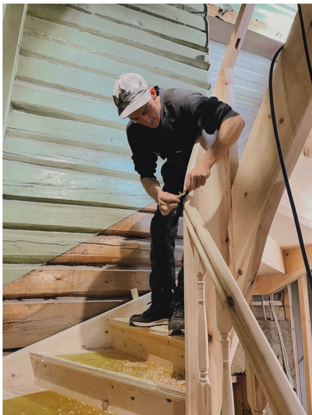
Figur 15. Tilforming av svingstykke med skavhøvel.
