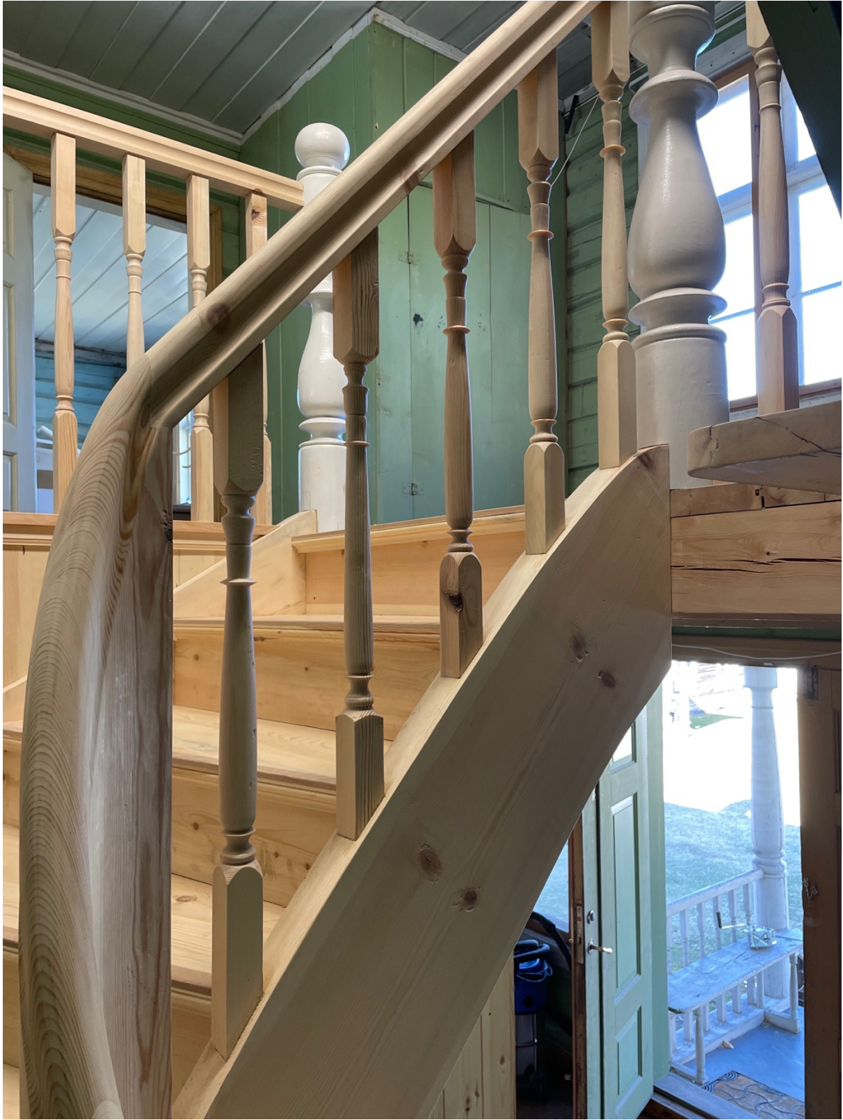
Figur 25. Detaljbildet baluster ved øvre frivangen.
