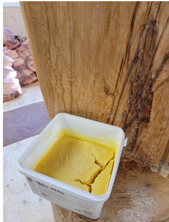
Bilde 65: Siste finishen ble gjort med sikling og til slutt ble spindelen bonet med selvlaget voks, slik den var i 1665.
