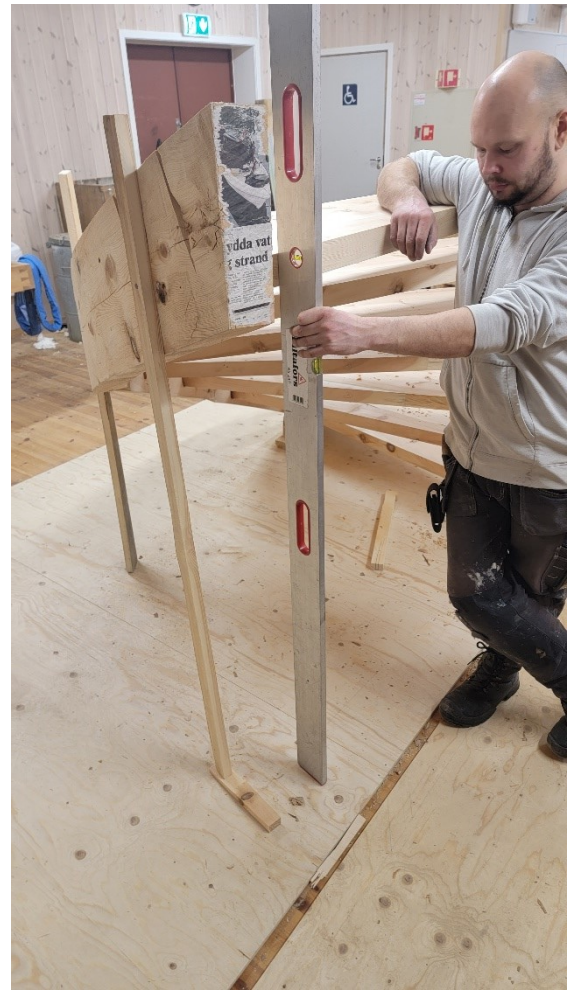
Bilde 54: Hele tiden ble delene justert etter oppslaget.
