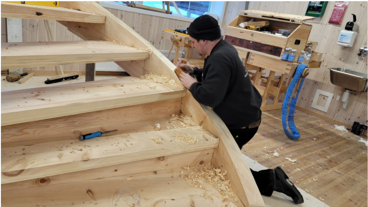
Bilde 55: Så måtte vangens overkant høvles i plan.
