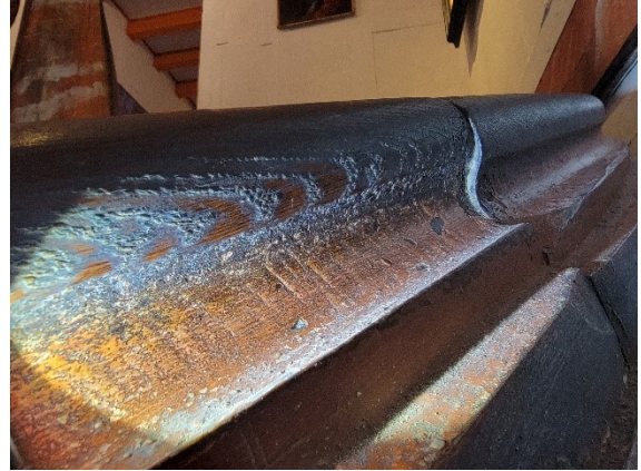
Bilde 78 og 79: Det oppstår liknende verktøyspor som på original håndrekken, under høvelprosessen.
