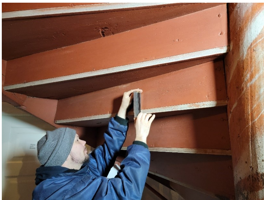
Bilde 39: Profilkamm er et nyttig verktøy som er både rimelig i anskaffelse og lett å ta i bruk. Med hjelp av dette verktøyet var det lett å finne ut at profilen var brukt flere steder, bla på. trinnese, meglerbordet, vangens underkant og dekklist. Samme profil var også ved inngangsdøren. Det kan tyde på at døren og trappen ble produsert i samme snekkeri.
