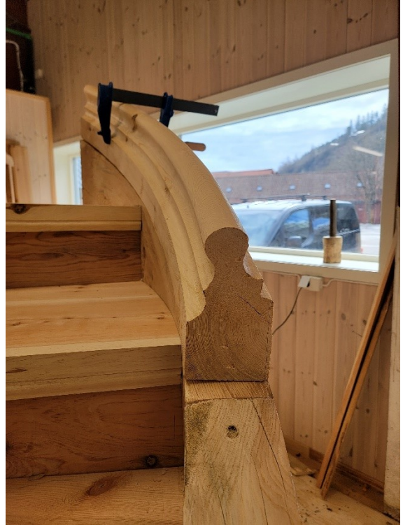
Bilde 81: Finishen ble også her utført med sikling.
