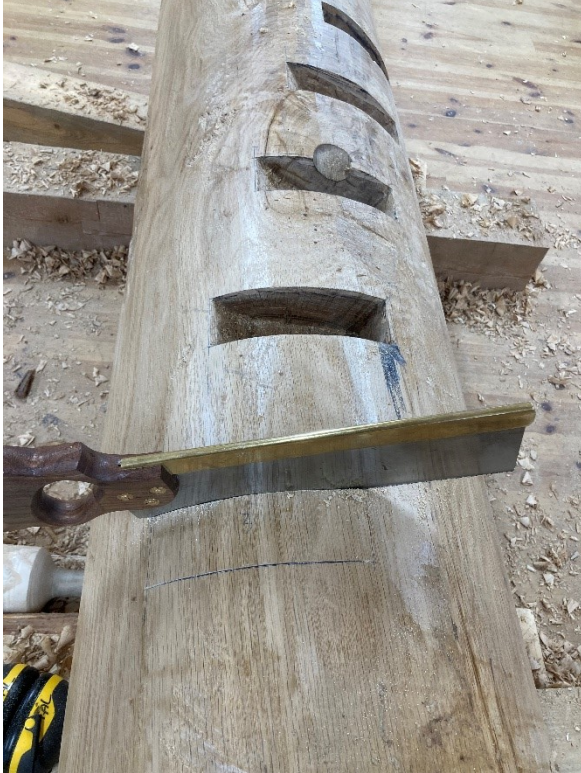
Bilde 48: Trinnene blir felt inn i spindelen
