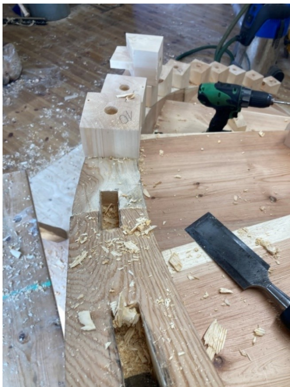
Bilde 82: Balustrene måtte stemmes inn i både i vangen og håndrekken.
