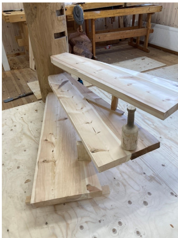
Bilde 51: Trinn for trinn ble trappen satt sammen over grunnrisset.
