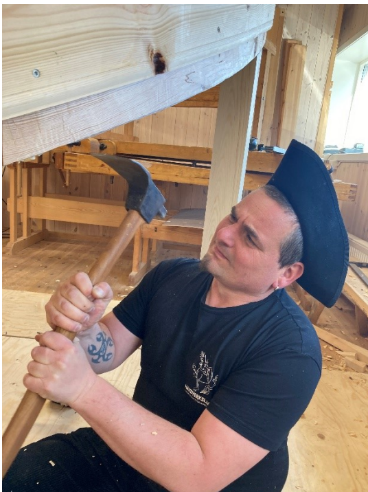
Bilde 86: Undersiden av vangen justeres med skarvøks. Resultatet ble litt finere enn ved originalen, hvor det er tydelige øksespor etter tilpassingen.
