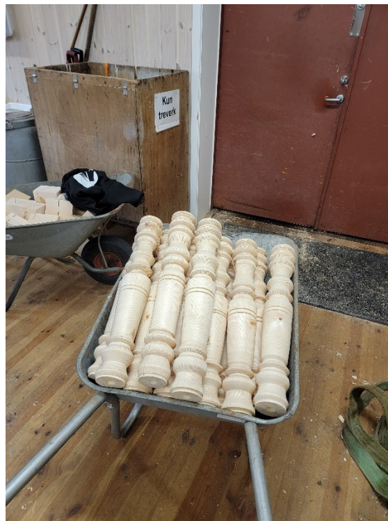
Bilde 72: Balustrene er klar til montering.
