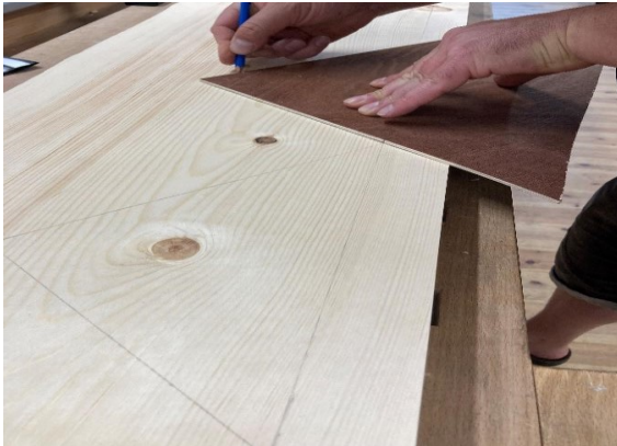
Bilde 25: Her vises prinsippet med å finne stigningsvinkelen. En rettvinklet trekant med trinnenes inntrinn og oppriss mål, brukes på en hjelpe linje og tegnes rundt.
