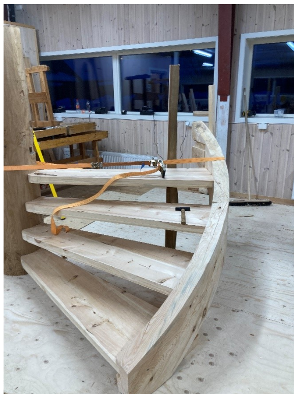
Bilde 52: Stropper måtte til for å tvinge trappen sammen.
