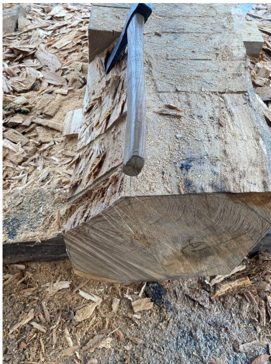
Bilde 43: Fra 4-kant gikk det over til 8-kant.
