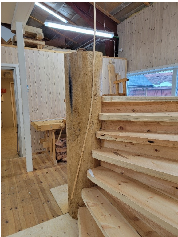
Bilde 57: Med hjelp av den digitale 3D-modellen ble handrekkens plassering på spindelen avgjort.
