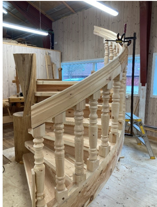
Bilde 85: Til slutt ble hele gelenderet montert.
