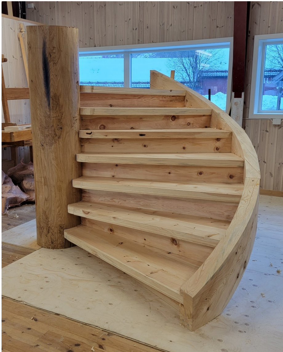
Bilde 56: Første milepæl var nådd etter 4 uker med hardt arbeid.
