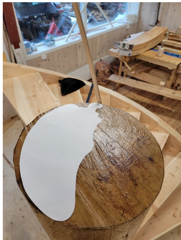
Bilde 58: Spindelens profil ble tegnet av på toppen med hjelp av en papirmal.
