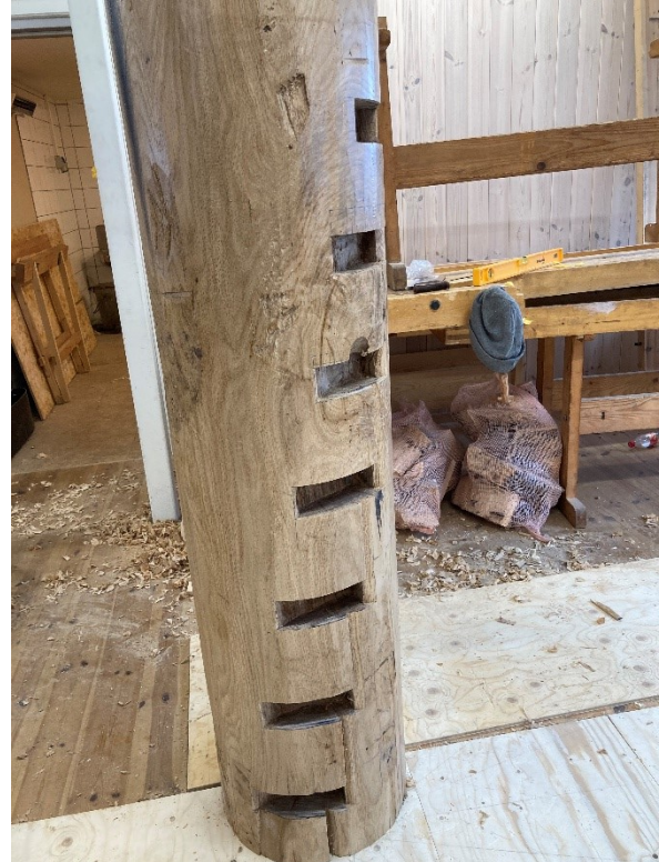
Bilde 49: Etterpå ble spindelen satt tilbake på oppslaget. For at trappen kan settes opp rundt den.
