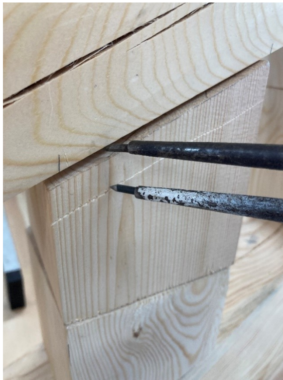
Bilde 83: Med hjelp av stikkpasser ble balustrene tilpasset etter vangen og håndrekken.
