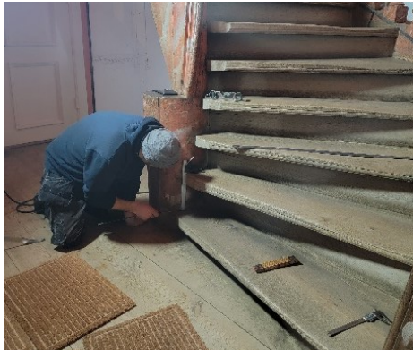
Bilde 6: Hvert enkelt opptrinn, inntrinn, trinndybde og bestikk på både inner- og yttervangen, ble oppmålt på millimeternivå.
