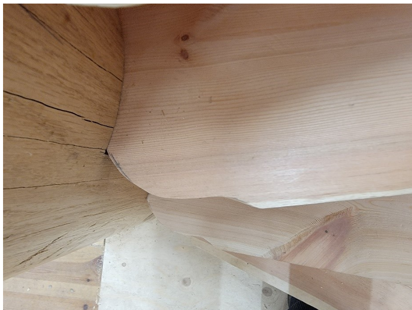
Bilde 24: Ferdig utformet distansekurve.
