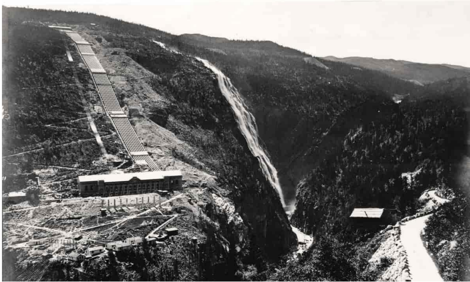
Bilde 2: Vemork kraftstasjon fotografert i 1911, like etter at den stod ferdig. Opphavsperson ukjent. Lisens: Falt i det fri (Public domain)
