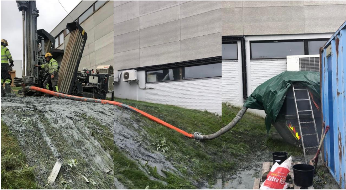
Figur 5.4: Slange mellom borehullet og kontaineren hvor det ble samlet inn kaks. Bildet er satt sammen av tre bilder og derfor ikke i riktig målestokk i forhold til hverandre.
