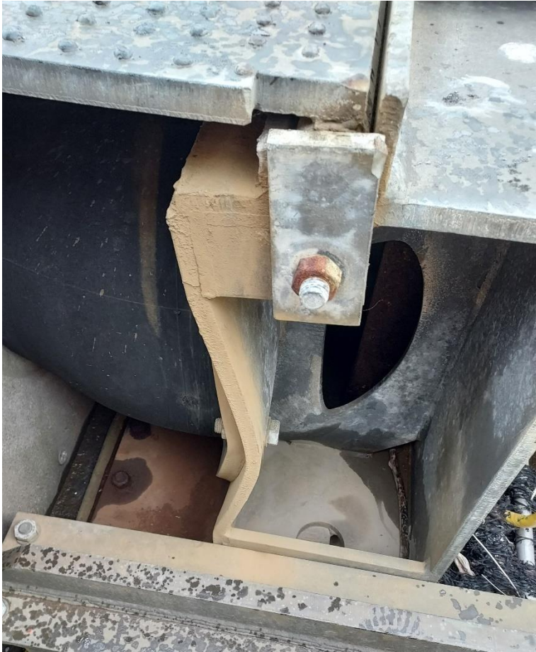
Figur 22 – Tilsvarende deformasjon på motsatt side av landkaret. Foto fra Inspeksjon.
