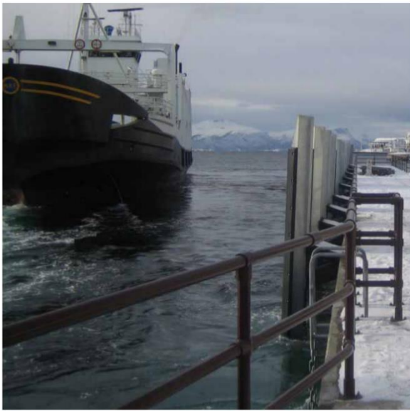
Figur 1 – Rekker med fenderverk på tilleggskai. Hentet fra V431 [2].
